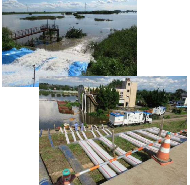
■ 西前原排水機場
