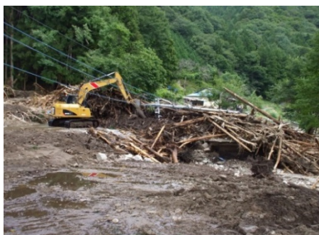
流出土砂撤去作業状況
