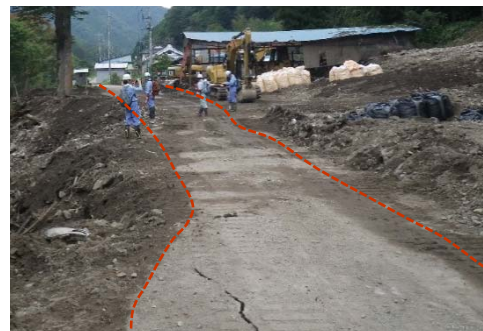
復旧された道路
