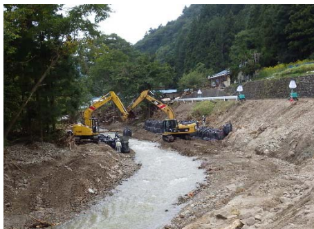
大型土のうによる応急復旧状況
