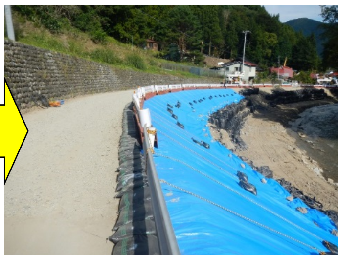
応急復旧完了状況
