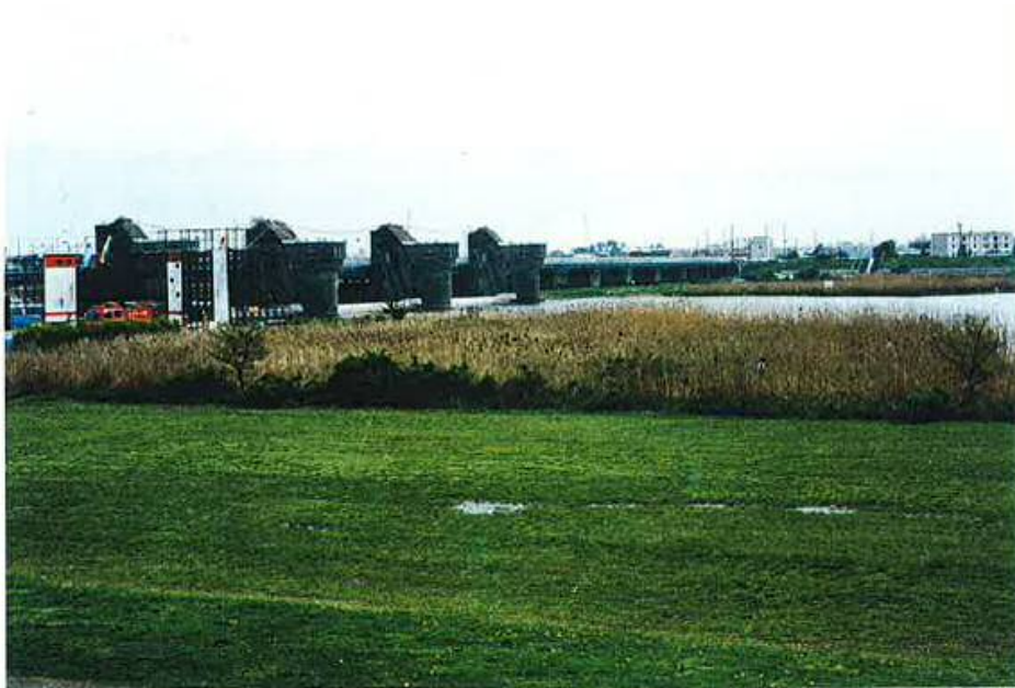
写真 2. 1 堰上流左岸のヨシ原の状況 (H7)
