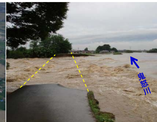
被災状況(拡大写真)
