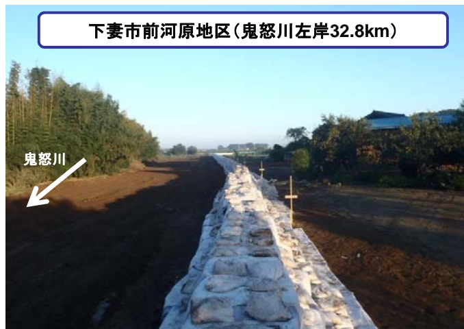
9月23日 大型土のう設置終了 (L=340m)
