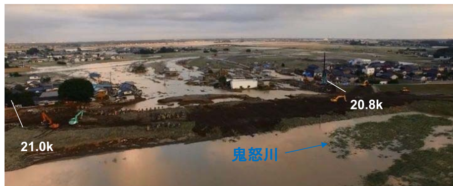
応急復旧状況(9/12)
