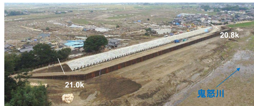
応急復旧状況(9/24)
