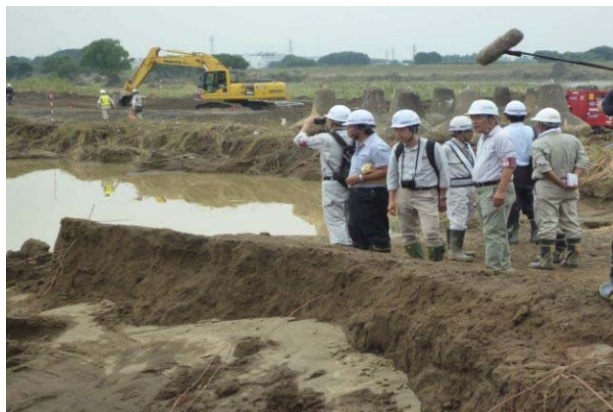
委員による現地調査
