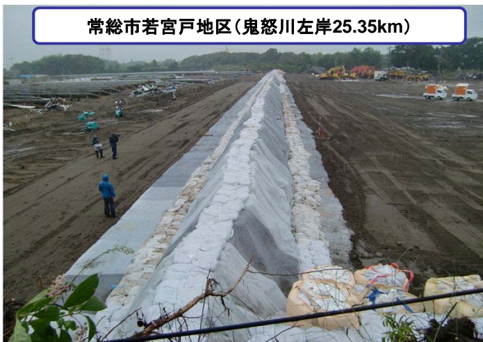
9月16日 大型土のう設置終了 (L=209m)
