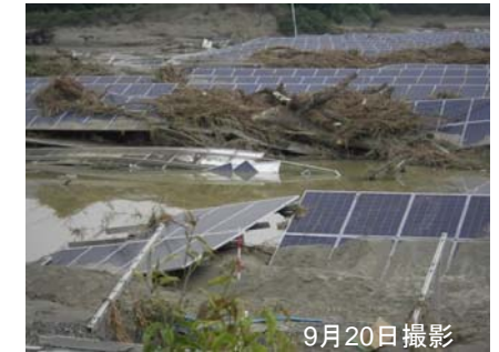
② 溢水箇所(25.35k付近) 被災状況
