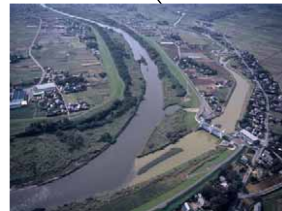
伊丹排水機場
