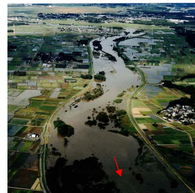
平成16年10月洪水41km付近 (愛国橋上流)
