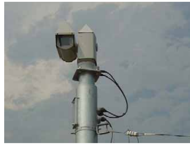
洪水の状況把握 (水位・流量観測所、CCTVカメラによる監視)
