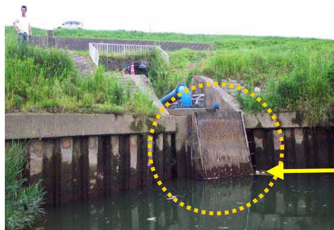
高崎揚水樋管
