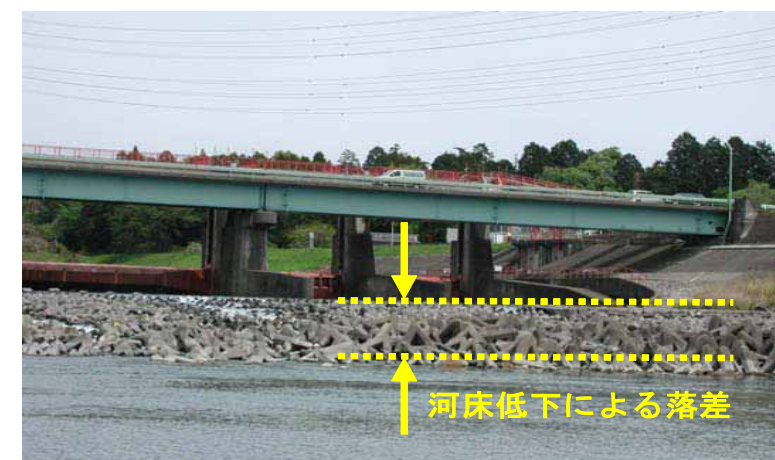
勝瓜頭首工下流部
