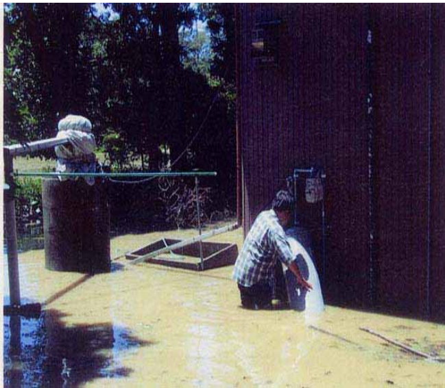
平成 14 年 7 月洪水 無堤部浸水状況 常総市豊岡町地先
