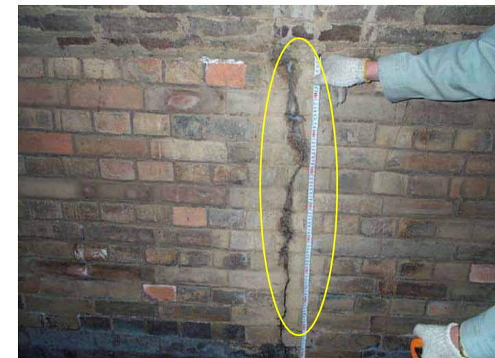
江口排水樋管
