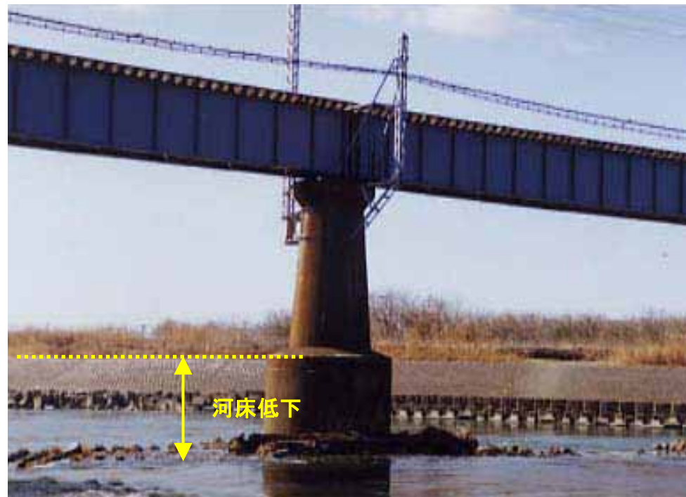
J R水戸線鬼怒川橋梁
