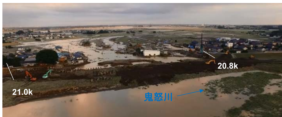
応急復旧状況(9/12)
