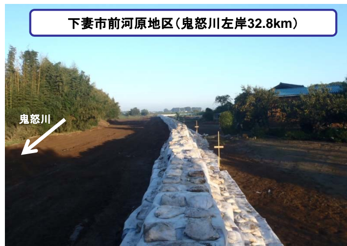
9月23日 大型土のう設置終了 (L=340m)
