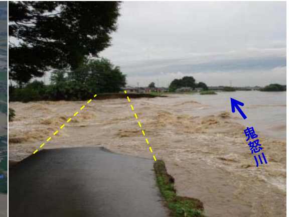
被災状況(拡大写真)
