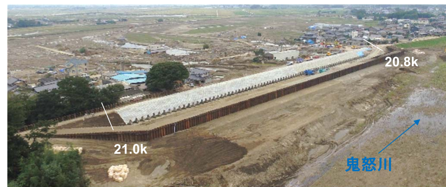
応急復旧状況(9/24)
