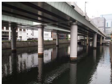
→河川の上に高速道路が走り、完全に川とまちが切り離された空間となっている。
