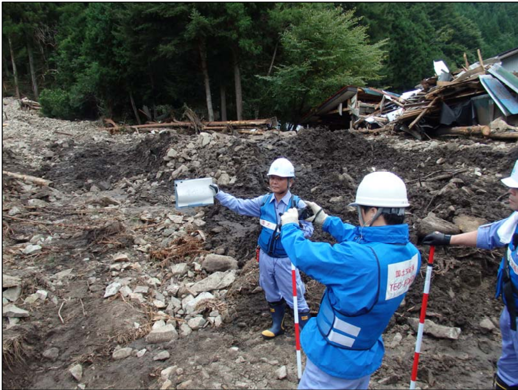
土石流の被害状況を調査する TEC-FORCE 隊員（日光市滝向沢）
