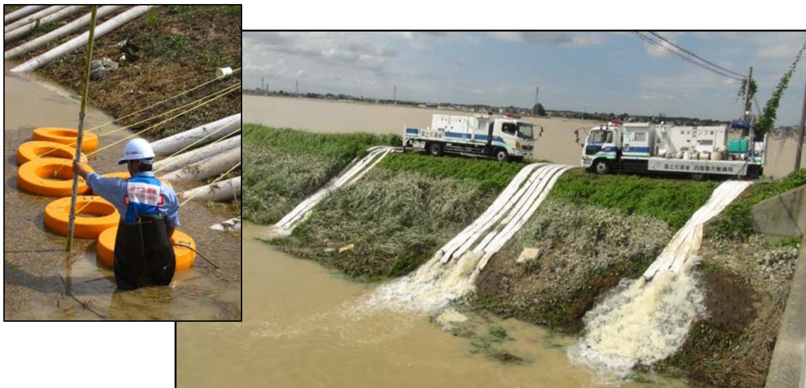
浸水した地域にて「排水ポンプ車」を用いて排水作業を実施
