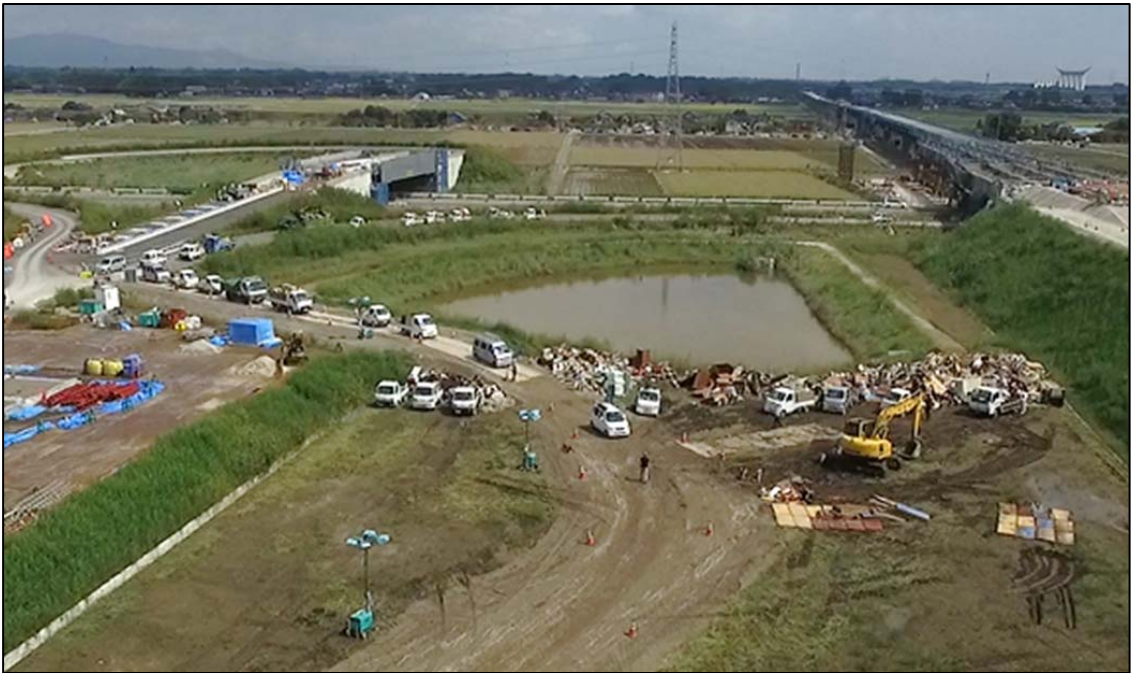
圏央道（建設中）常総 I C 予定地への粗大ゴミ受け入れ（9/19 受入開始時）
