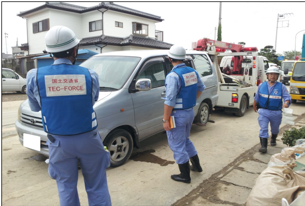
緊急車両の通行を確保するため、常総市道に放置された車両の移動を行う道路の啓開作業
