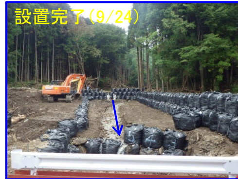
大型土嚢積による 仮排水路
