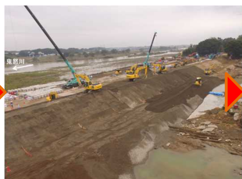
川裏から上流 (9月16日6:00頃撮影)
