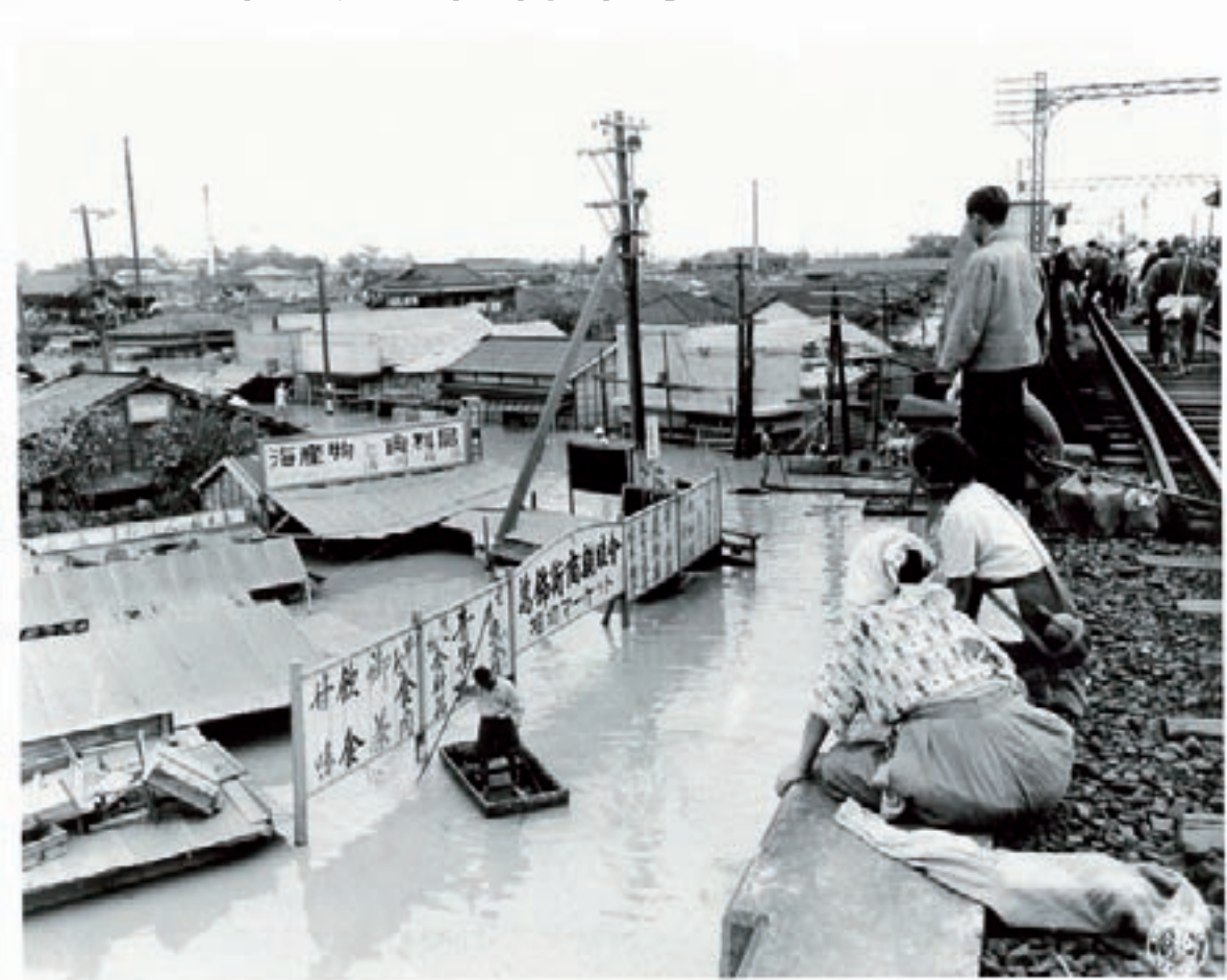
S22.9.21 葛飾区浸水状況
