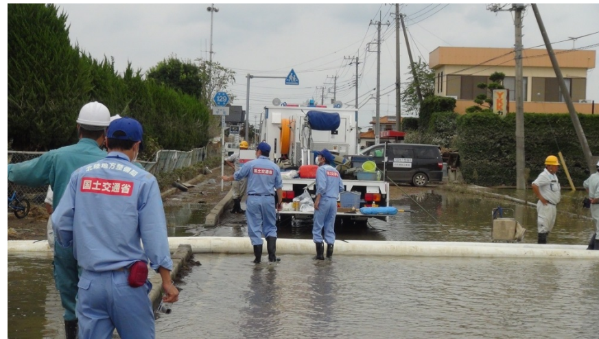
(大生小学校周辺の排水作業状況)
