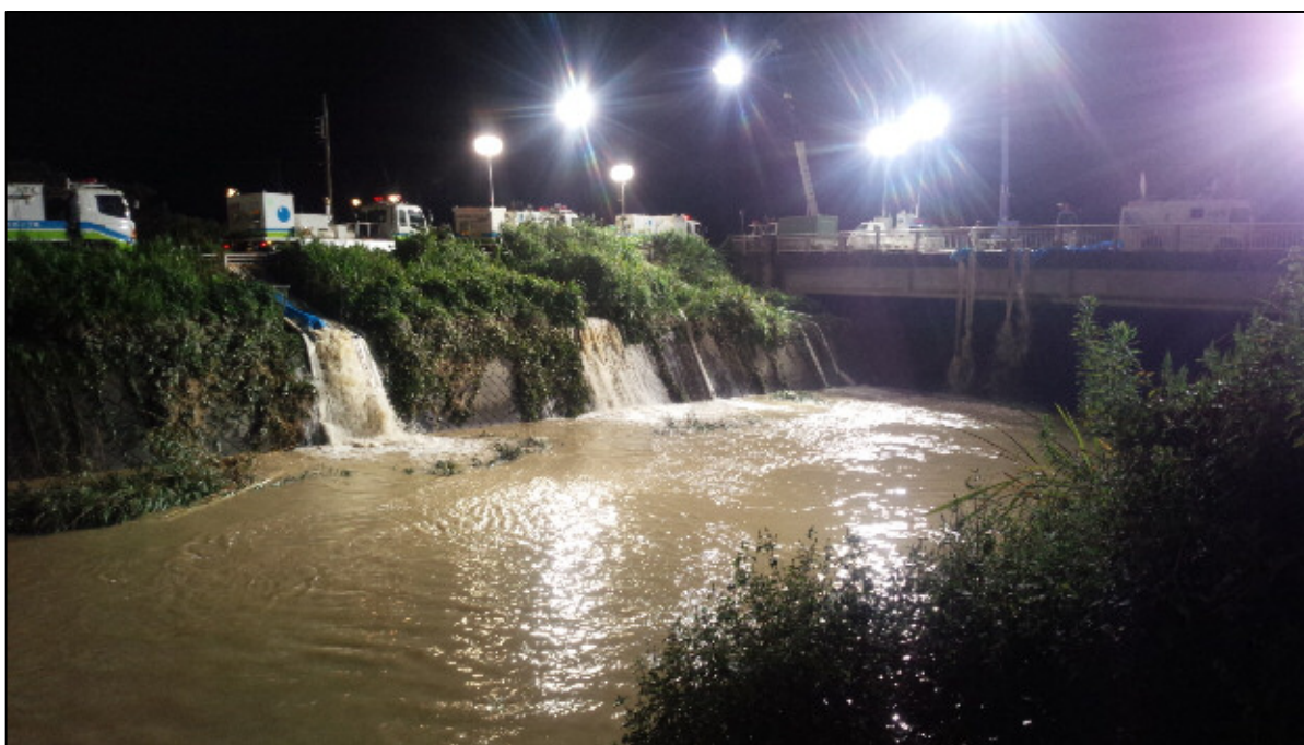
排水作業を 24 時間実施するため「照明車」を設置
