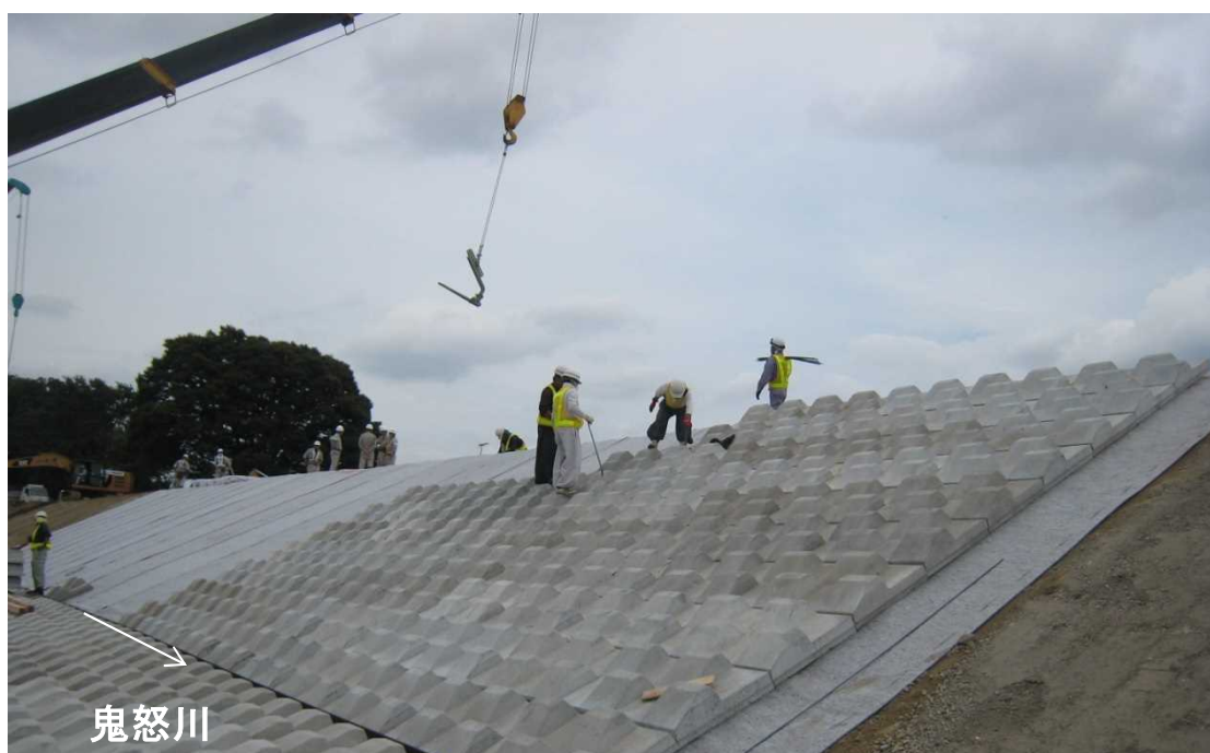
法覆工の施工状況（川表側より下流から上流をのぞむ）
