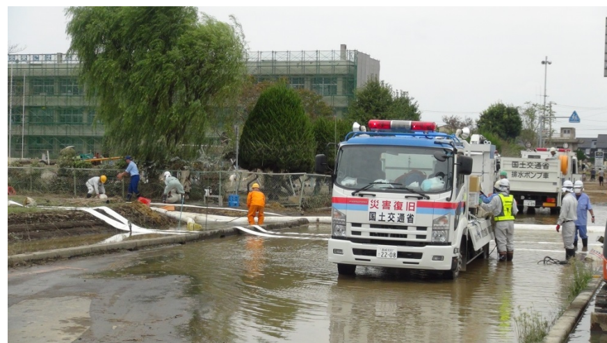
(大生小学校周辺の排水作業状況)
