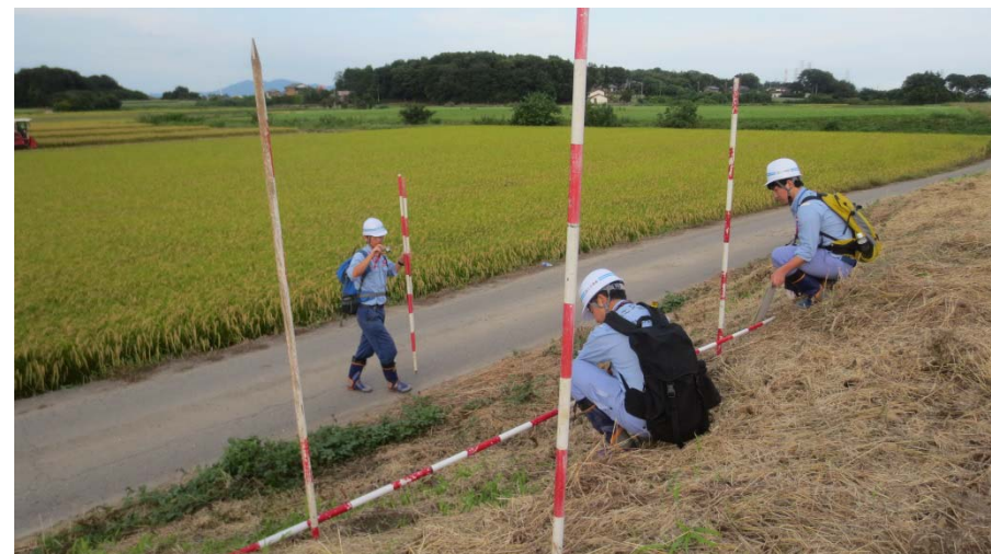
(茨城県下妻市仲居指地先(鬼怒川左岸30.0km)) 16時撮影
