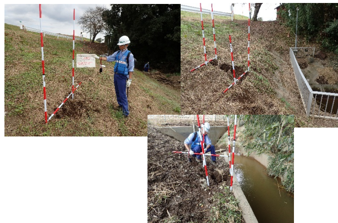
(茨城県八千代町大渡戸地先(鬼怒川右岸38.1km:大渡戸樋 管))12時30分撮影
