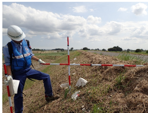
(茨城県結城市山王地先(鬼怒川右岸38.5km))12時50分撮影
