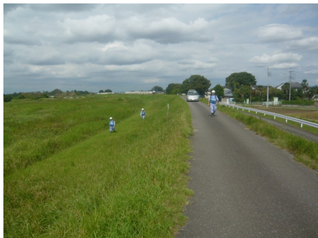
(栃木県真岡市掘込地先(鬼怒川左岸56.25km)) 13時30分撮影
