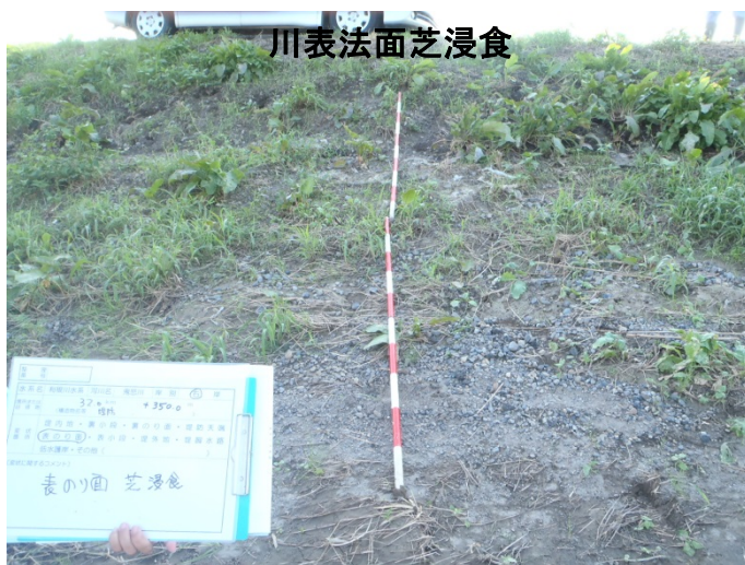
(茨城県八千代町今里地先(鬼怒川右岸32.35km))16時撮影
