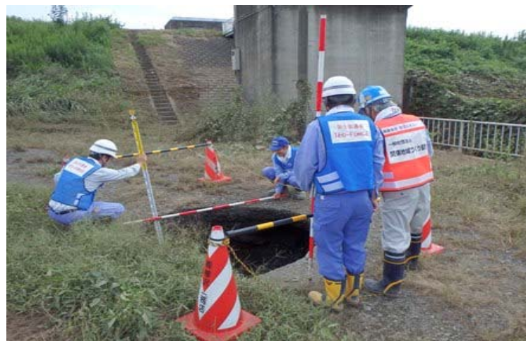
川裏陥没確認
