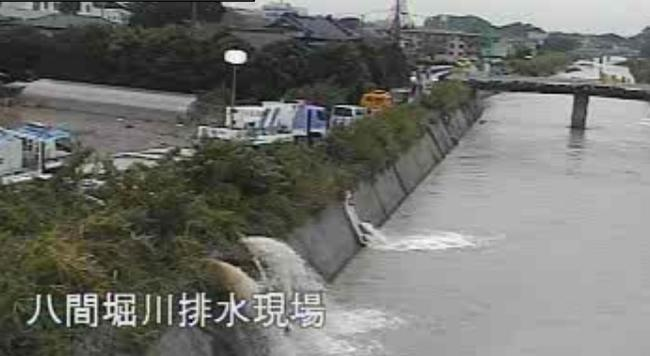
排水ポンプ車等の稼働により、これまでに浸水した範囲から概ね69時間で約30km<sup>2</sup>減少(40km<sup>2</sup>→10km<sup>2</sup>)
