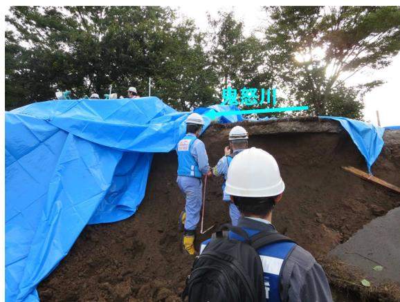
決壊箇所 上流端の堤防断面の調査
