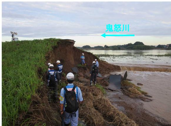
決壊箇所 下流端の堤防断面の調査
