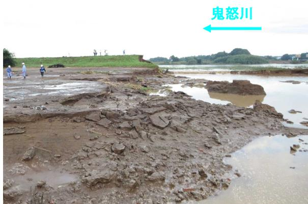
居住地側 地盤面の洗掘状況
