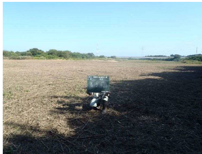
写真②: 着工前(上流から下流を望む)
