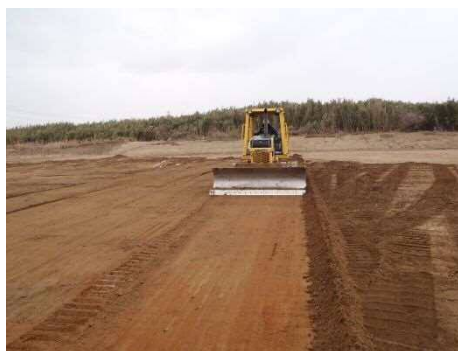
ブルドーザ(敷均し)
