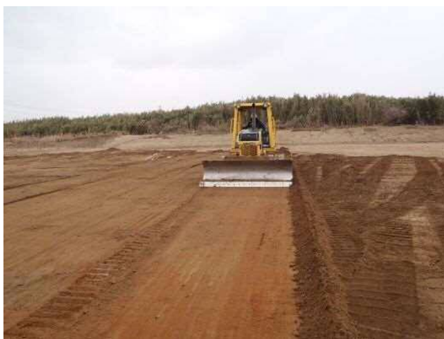
ブルドーザ(敷均し)
