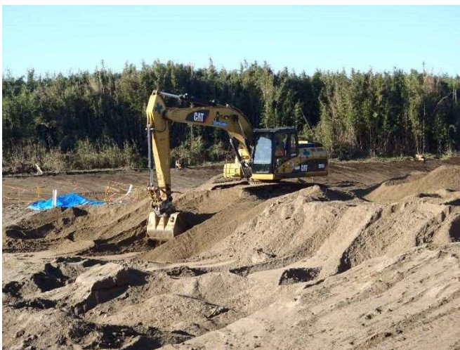
写真⑦: 掘削状況
