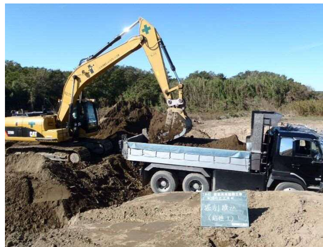
写真⑧: ダンプトラック積み込み状況
