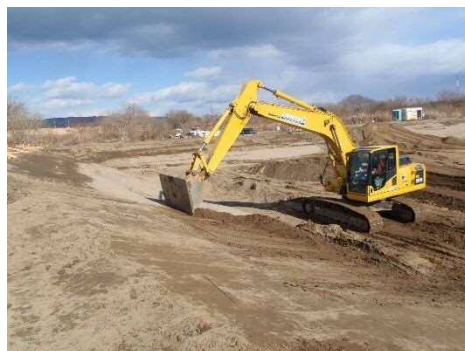
バックホウ(掘削・法面整形)
