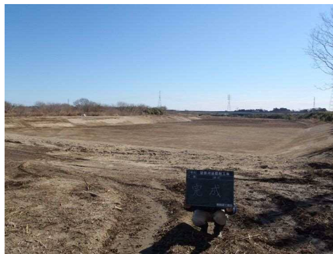
写真④: 完了後(上流から下流を望む)
