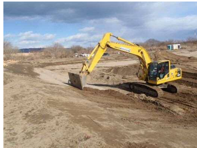
バックホウ(掘削・法面整形)
