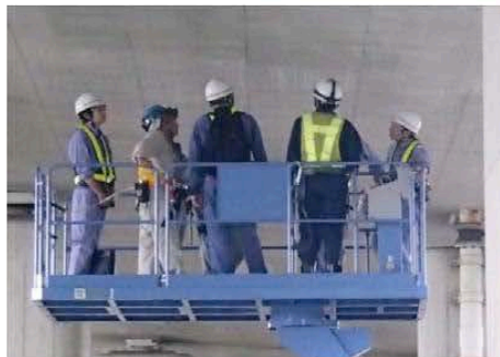
高所作業車による点検事例
