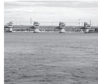
行徳可動堰は江戸川放水路の入口に位置し、塩水の遡上を防止し、堰上流で安定した取水ができるようにする機能と、江戸川の洪水を安全に流下させる機能の2つの役割を持っています
