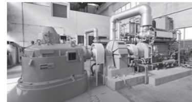
古ヶ崎排水機場の樋管（写真上）とポンプ（写真左）。大雨時には松戸市内を流れる六間川に江戸川の水が逆流しないようゲートを閉じるとともに、六間川の水位が増してきたら、ポンプでくみ出し江戸川へ排水しています
