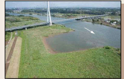
▲河道掘削試験施工地(那珂川下流部)
