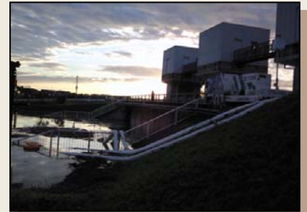
▲排水ポンプ車による排水状況 (H23年9月支川西田川)
