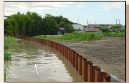
▲断面が不足している堤防
