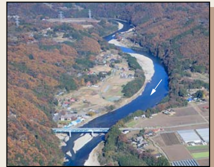
▲中流部の状況
