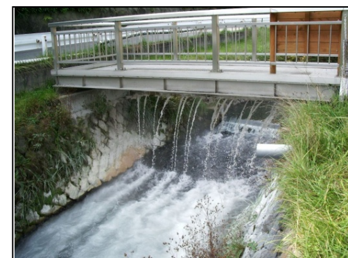
② 石灰石粉を投入し酸性河川を中和(湯川)
