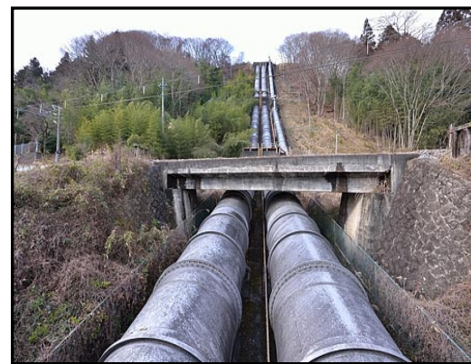
白砂川の水は繰り返し送水され利用(原町発電所の水圧管)
