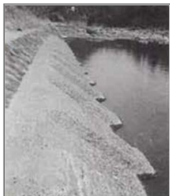
中和事業以前の護岸表面が劣化した護岸コンクリート
