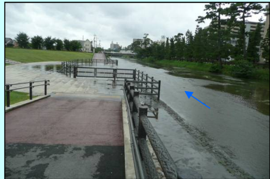
綾瀬川 14.6k付近(綾瀬川ラグーンより下流を撮影)
