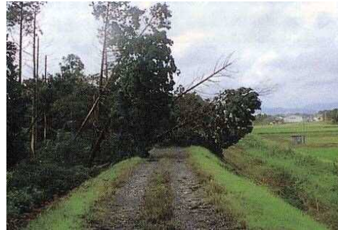
倒木により堤防へ影響
