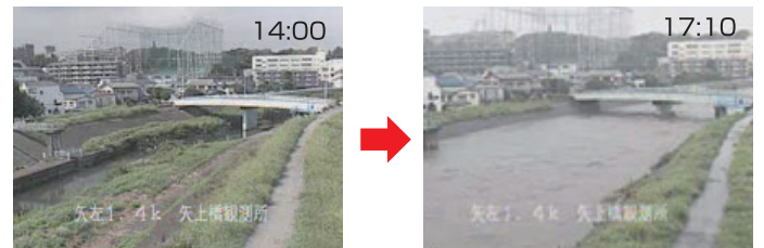
●局地的大雨（ゲリラ豪雨）の例 平成 23年8月26日 矢上川矢上橋
