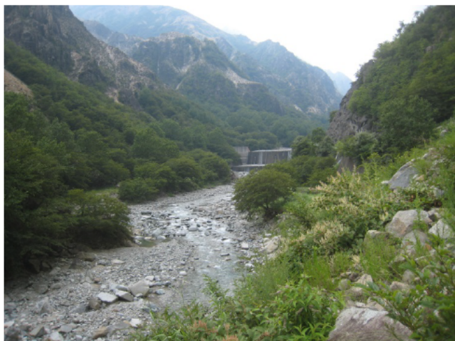
松木川五号砂防堰堤
