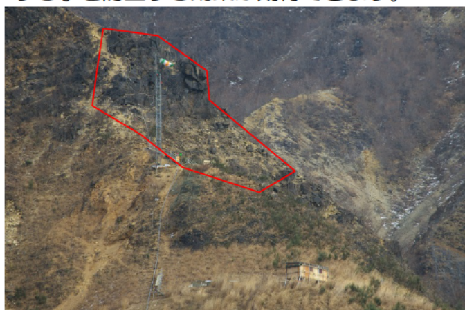
工事前の現場周辺
