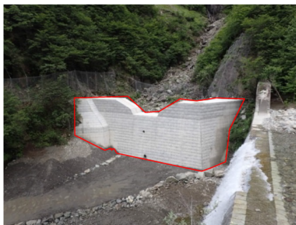
工事完成後 (奥にある施設が今回工事しました谷止工です)
