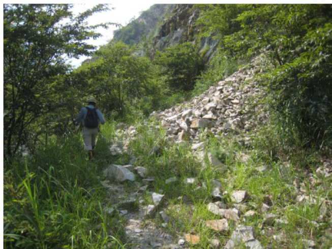
巡視路の土砂崩れ箇所 (数箇所、土砂崩れが発生している所がありました)
