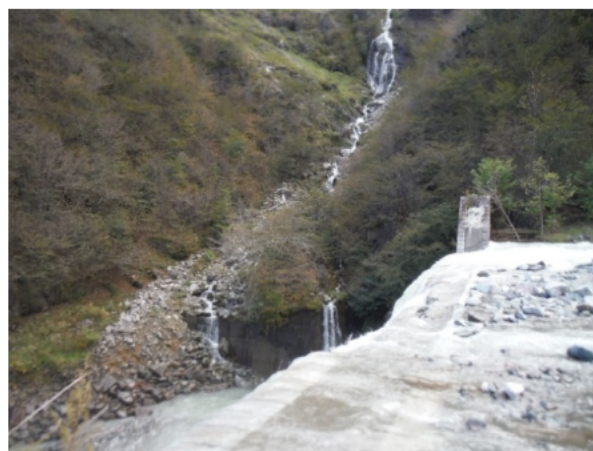
工事前の現場周辺 (手前の堰堤が松木川一号砂防堰堤です)
