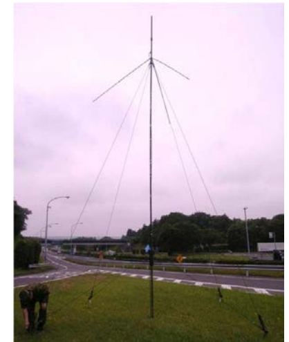
通信用アンテナの設置
