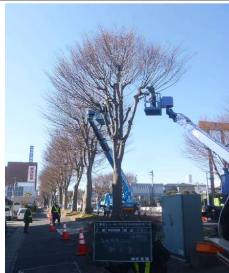
施工状況(樹木剪定)
