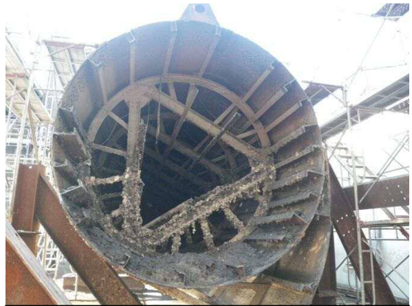
老朽化し、撤去されたゲート
