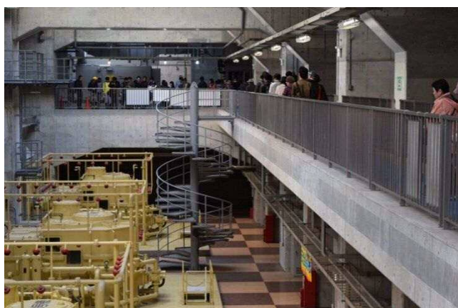
1年ぶりに特別公開したポンプ室 (左下に見える黄色いケースの中に航空機のエンジン転用した“ガスタービン原動機”などが収納されています。)
