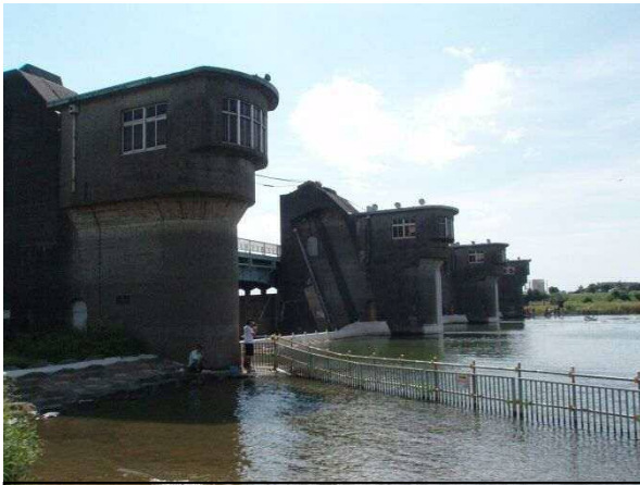
リニューアル工事前の行徳可動堰
