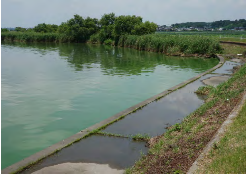
中岸 9.25km下 遠景
