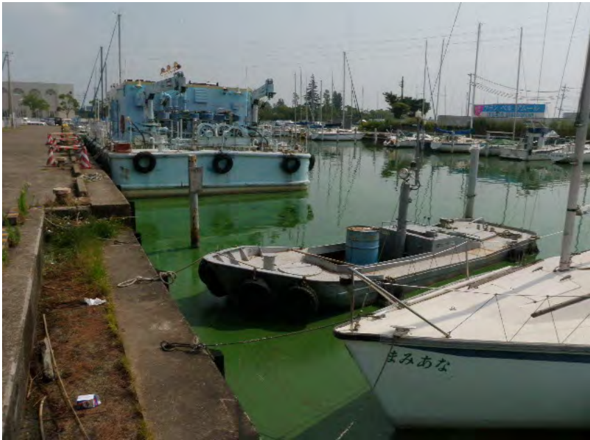
中岸1.25km+300m 全景
