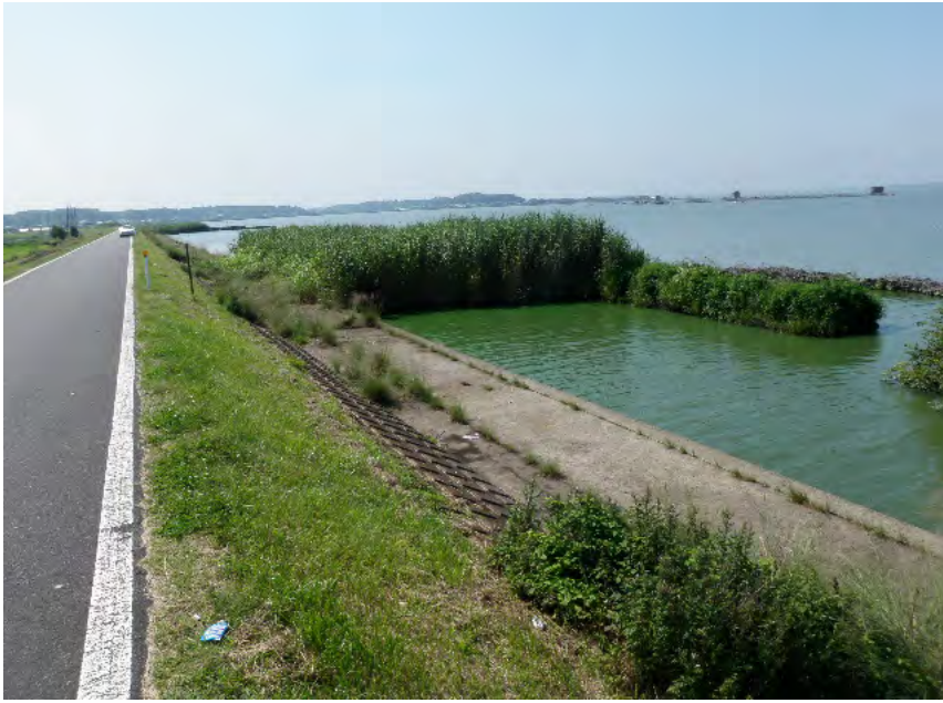
中岸23.50km下 遠景
