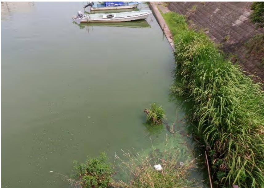
中岸 2.50km+150m 全景 同上
