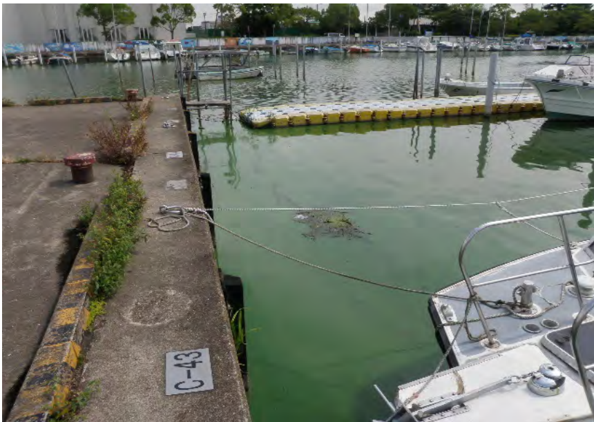
中岸 1.50km-200m 全景
