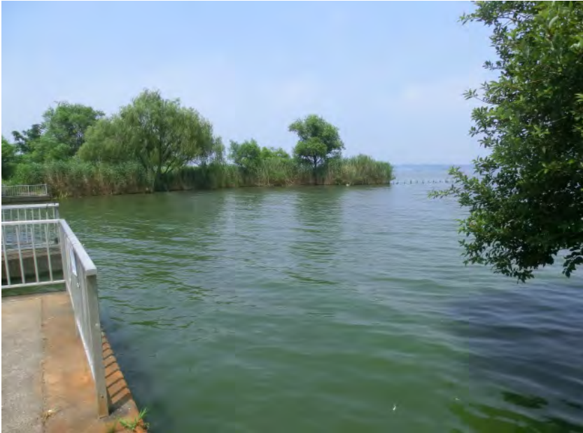
右岸47.25+100m 備前川水門前
