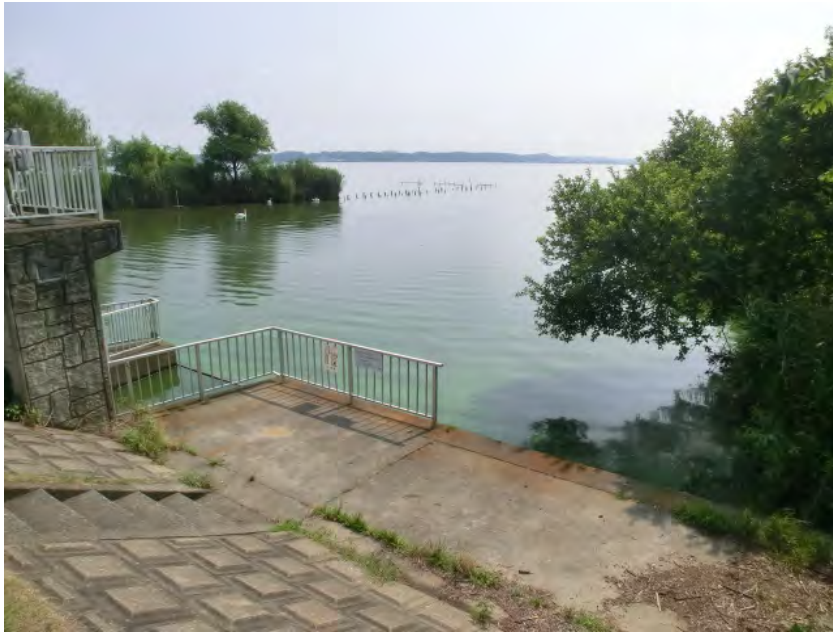
右岸47.25+100m 備前川水門前 遠景 レベル3~4 悪臭なし 一部湖面を覆っている箇所あり
