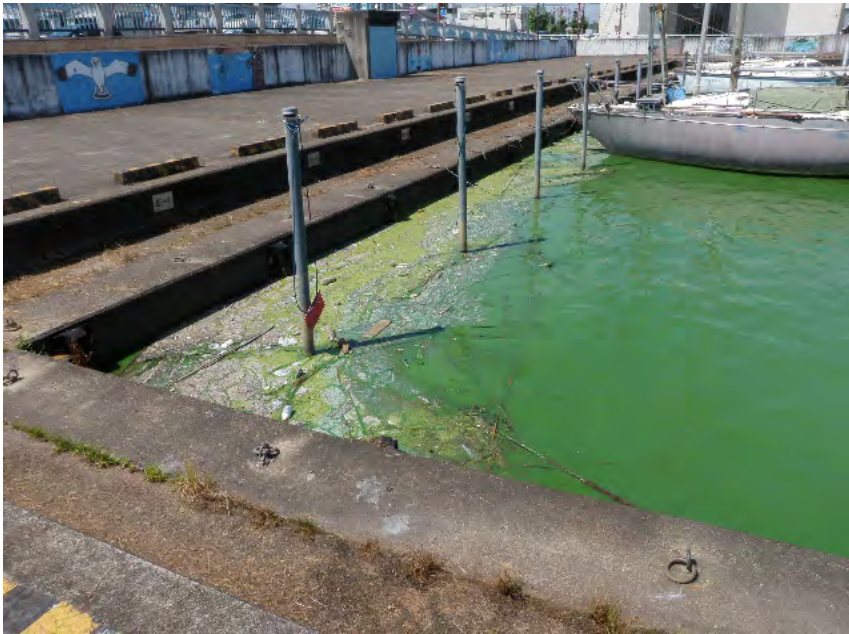
中岸 1.50km-150m 全景
