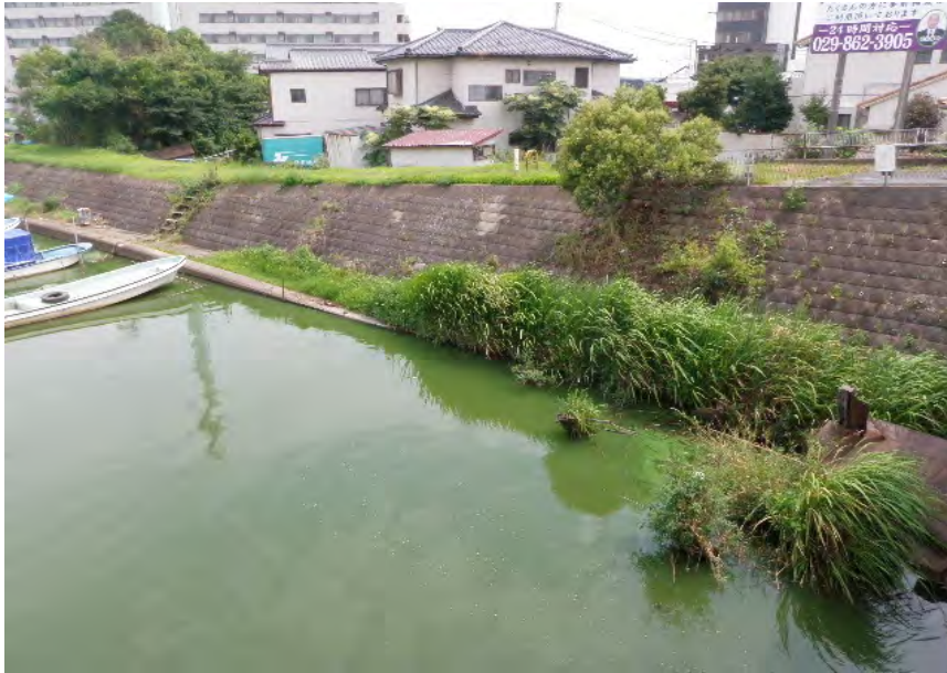
中岸 2.50km+150m 遠景 レベル2 悪臭なし
