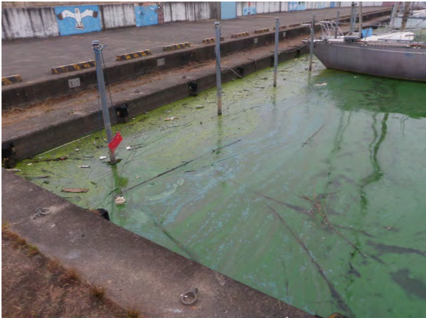
中岸 1.50km-150m 全景
