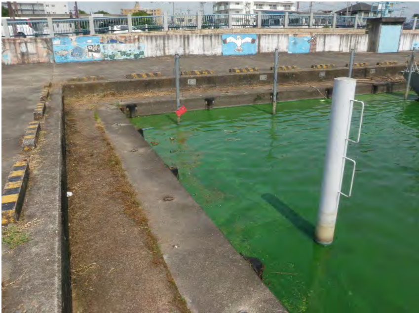
中岸 1.50km-150m 全景
