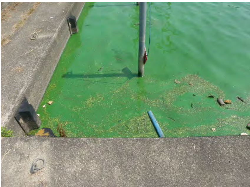
中岸 1.50km-150m 近景
