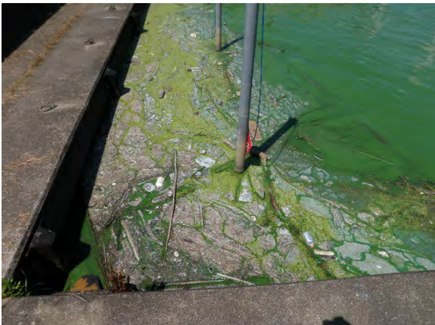
中岸 1.50km-150m 近景
