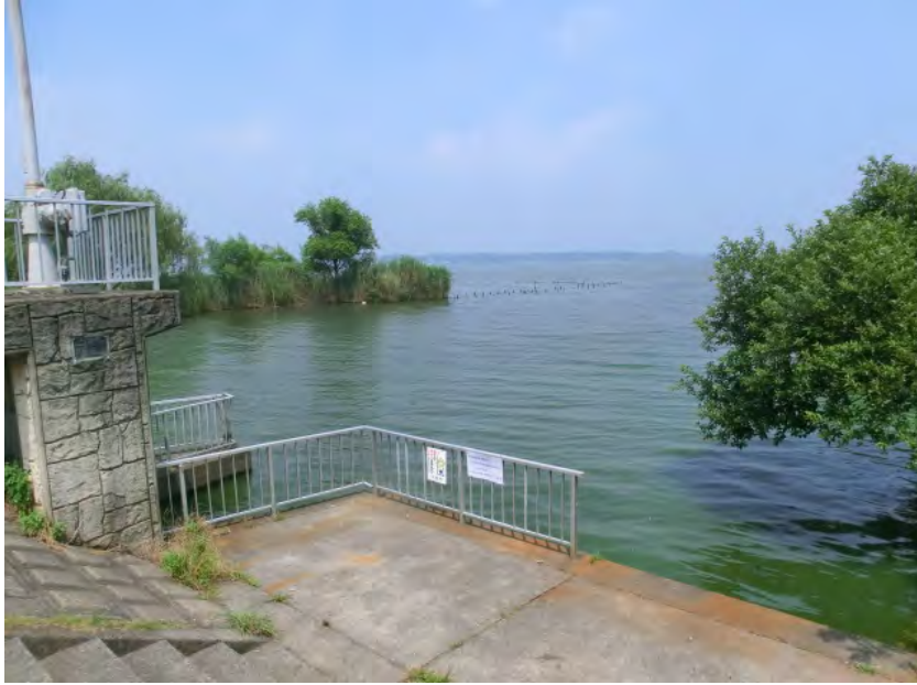
右岸47.25+100m 備前川水門前
