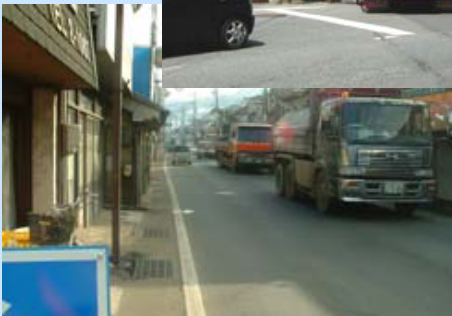
プロジェクト着手前の大型車の通行状況
