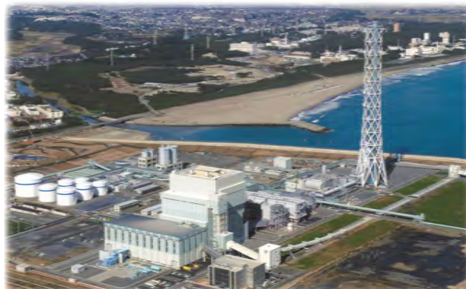
図2 常陸那珂火力発電所
