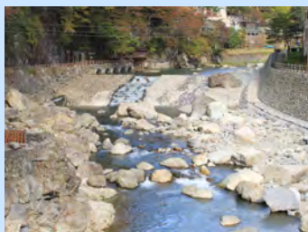
整備後の男鹿川
