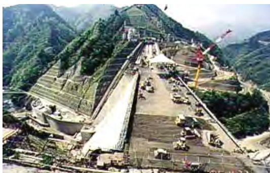
本体コンクリート打設状況
