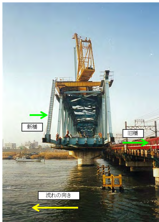
図4 架替工事の状況
