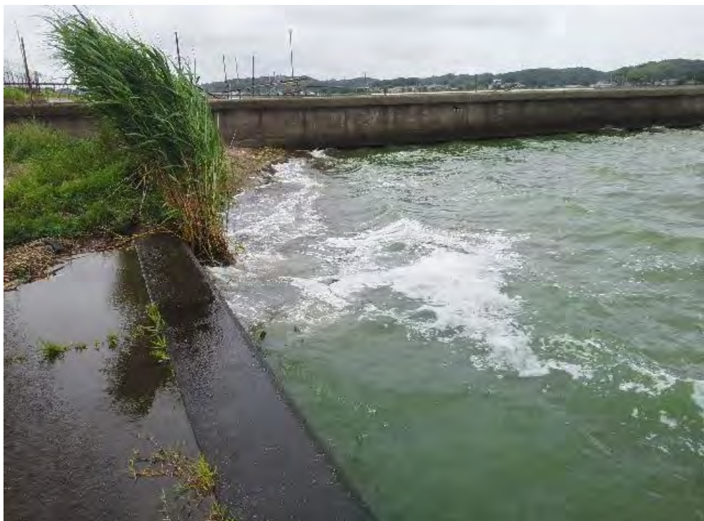
北浦右岸9.75km100m乙堀舟溜り下流側アオコ状況 レベル: 2 悪臭: 無
