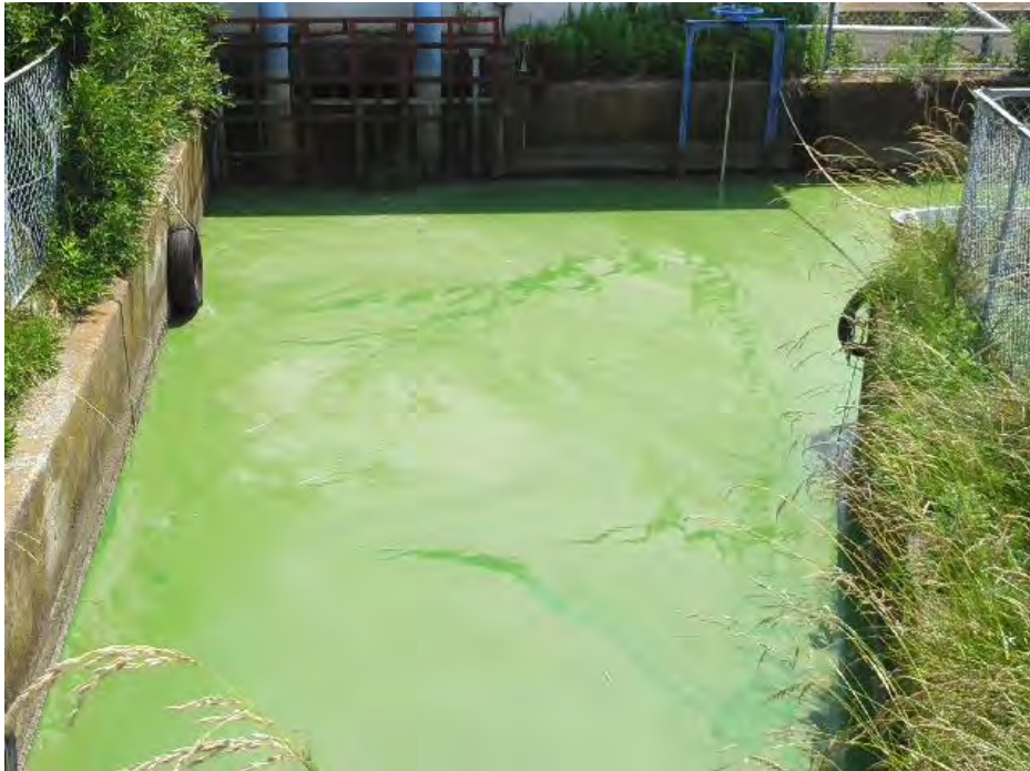
北浦左岸16.75km上幡木石津樋門内アオコの状況 レベル: 4 悪臭: 有
