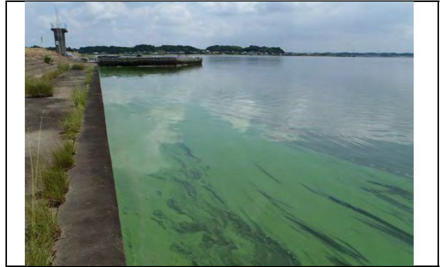
中岸32.50km+30m付近 レベル2~3悪臭無し
