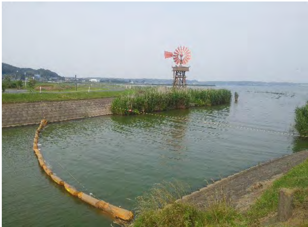
北浦右岸24.75km山田川河口オイルフェンス設置
