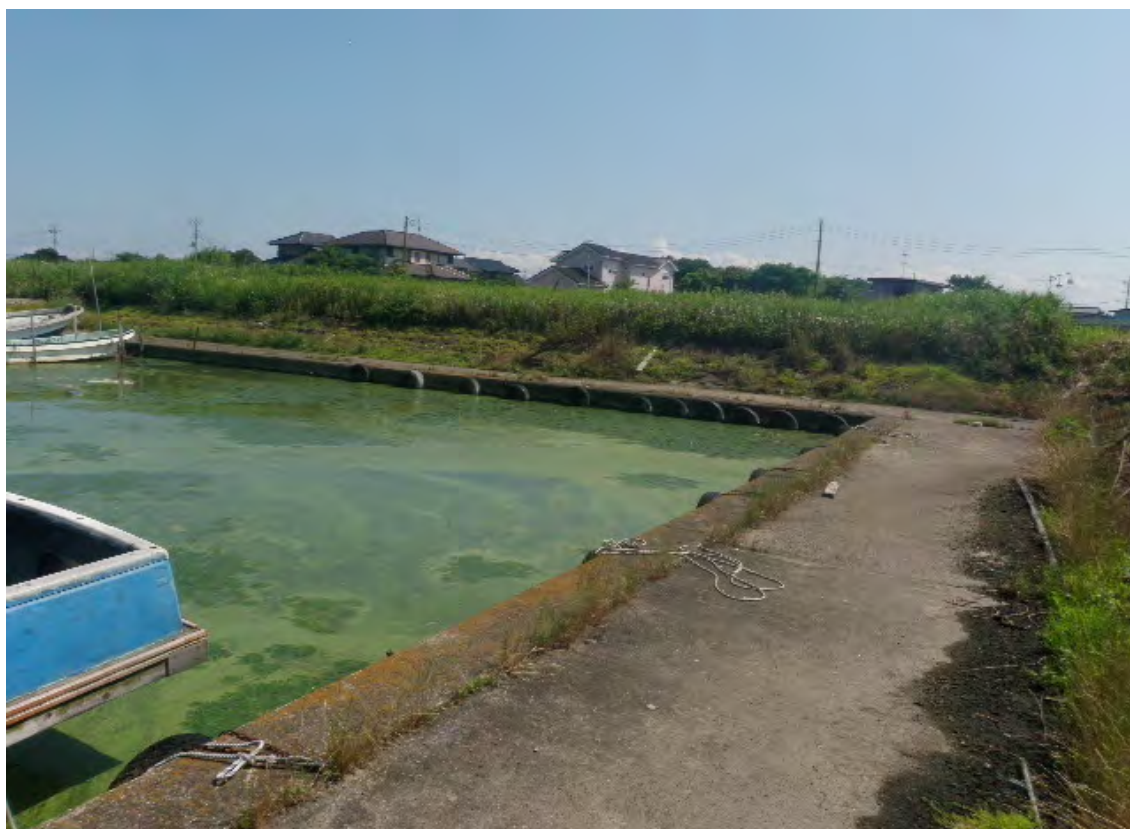
西浦中岸26.75付近 柏崎(上流)舟溜(遠景) レベル5 悪臭無し
