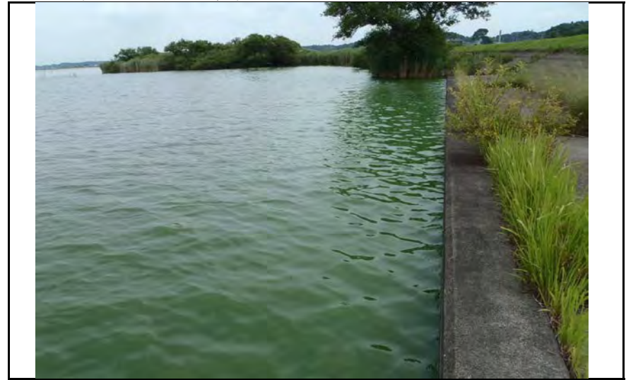
西浦左岸21.75km付近 総合的にレベル3 悪臭無し
