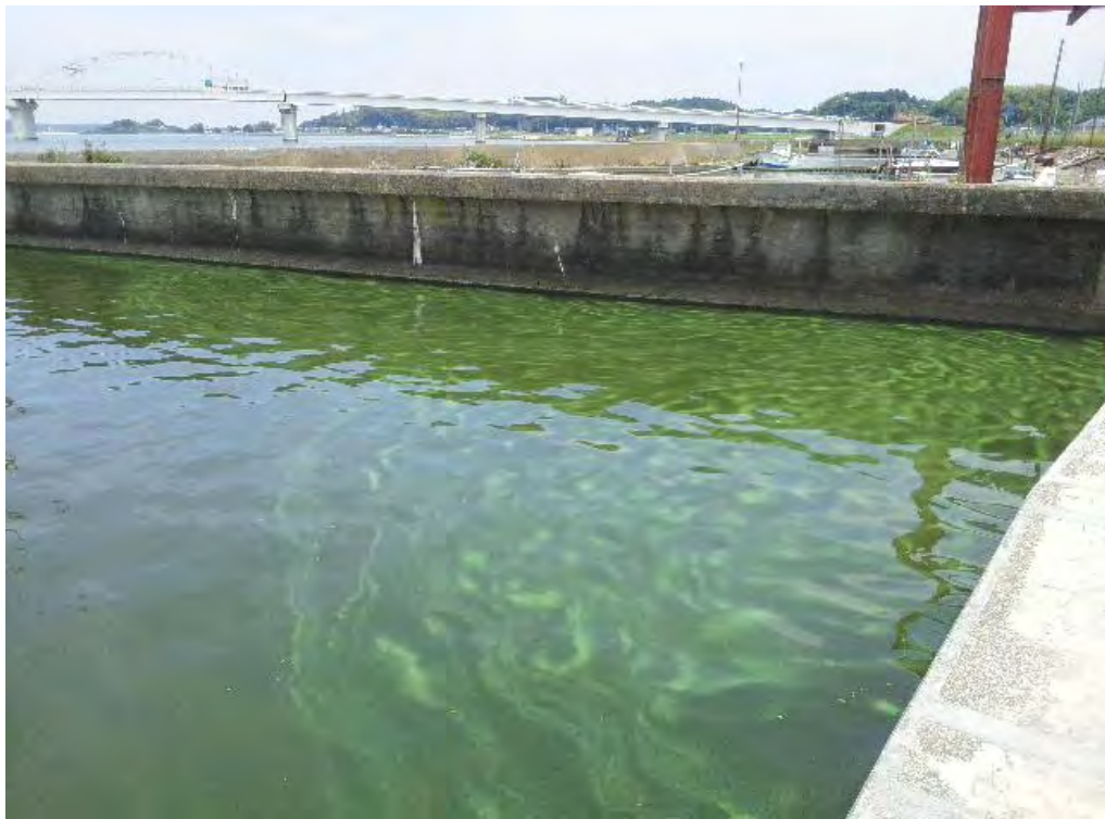
北浦左岸.19.25km-40m(札舟溜下流側)
