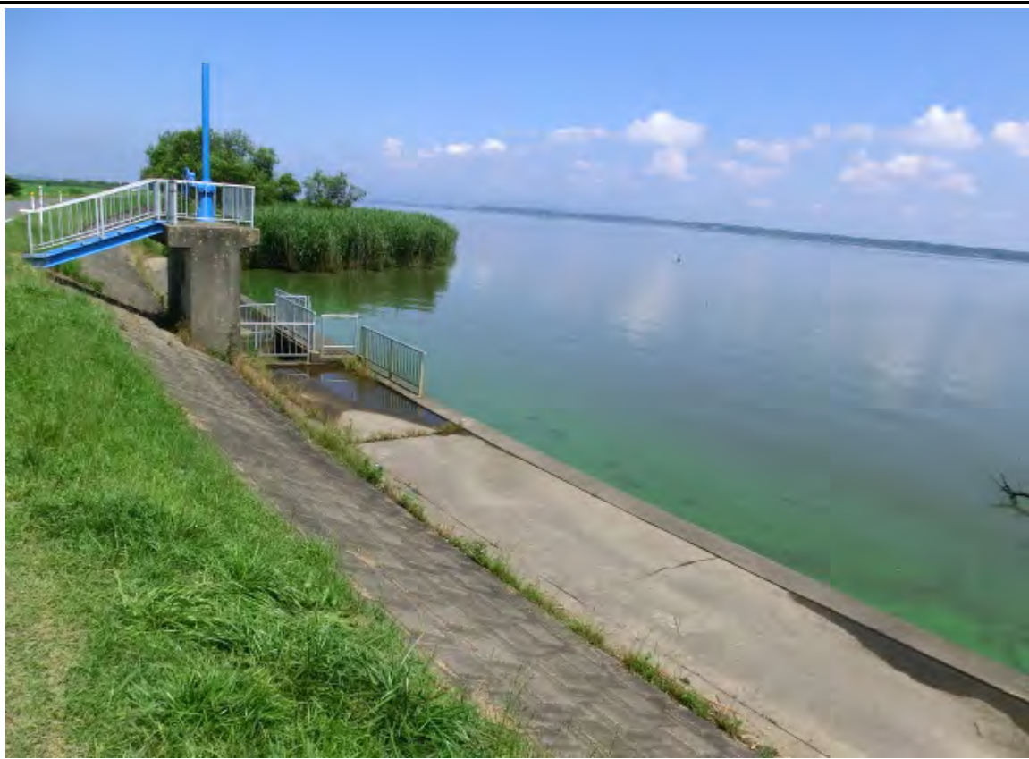
西浦右岸39.0付近、古屋排水樋管前(遠景) レベル2~4 臭気無
