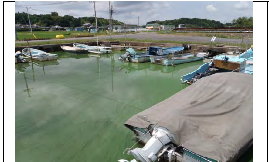
西浦中岸36.00km+220m坂井戸舟溜り樋門付近 レベル3 悪臭無し
