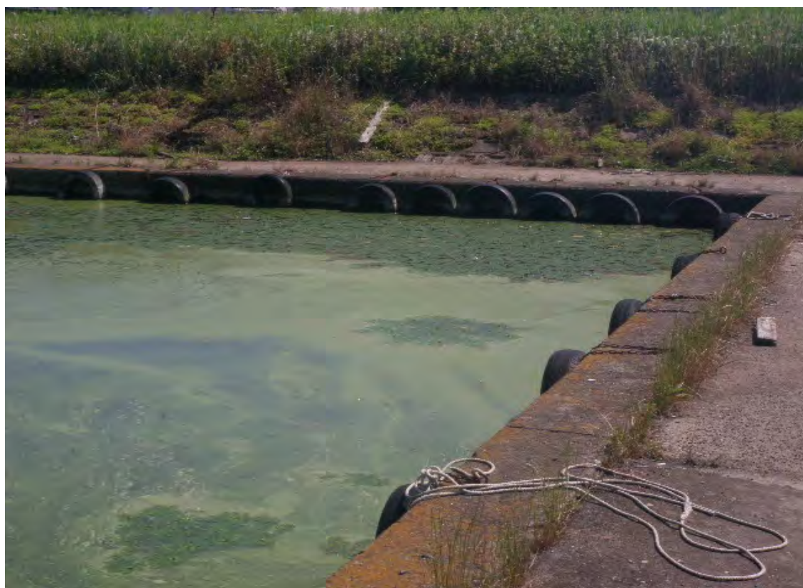
西浦中岸26.75付近 柏崎(上流)舟溜(全景) レベル5 悪臭無し
