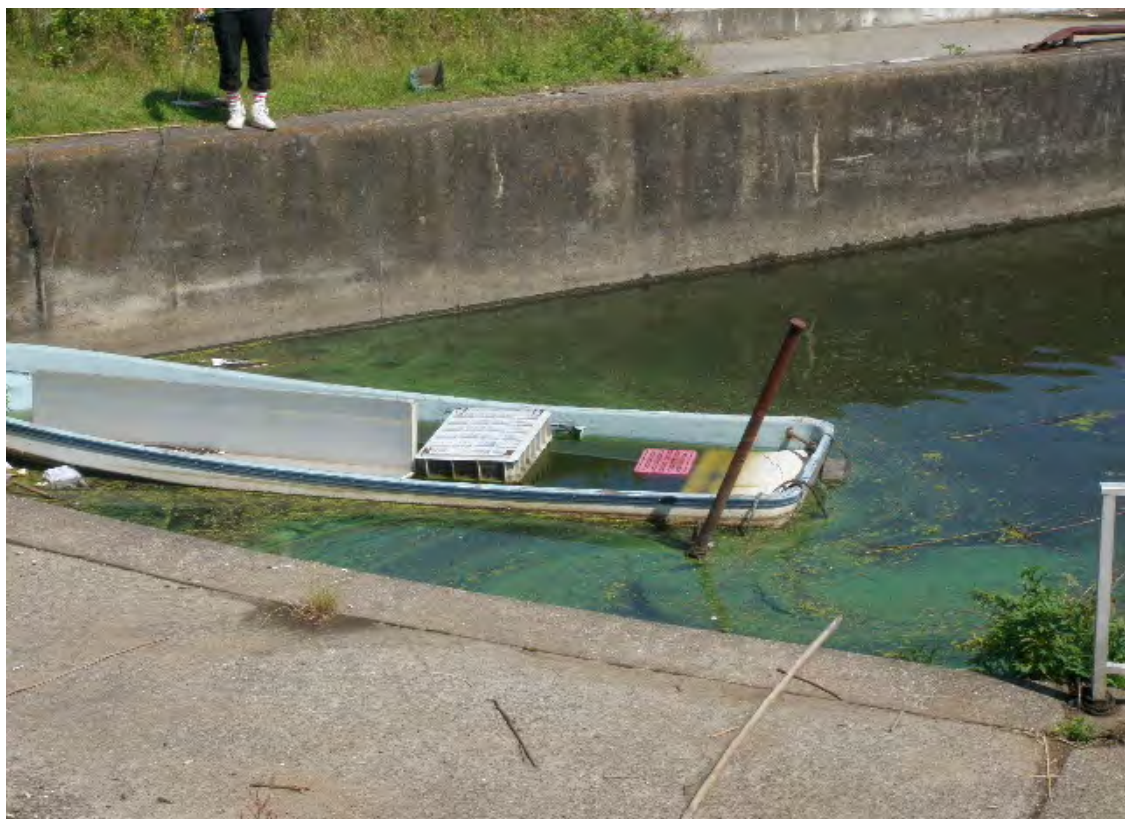
西浦中岸0.75付近 不動前樋管(全景) レベル3 悪臭無し
