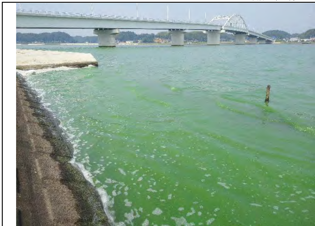
北浦右岸27. 5km 鹿行大橋下流
