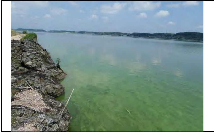
西浦中岸34.50km付近 総合的にレベル3 悪臭無し
