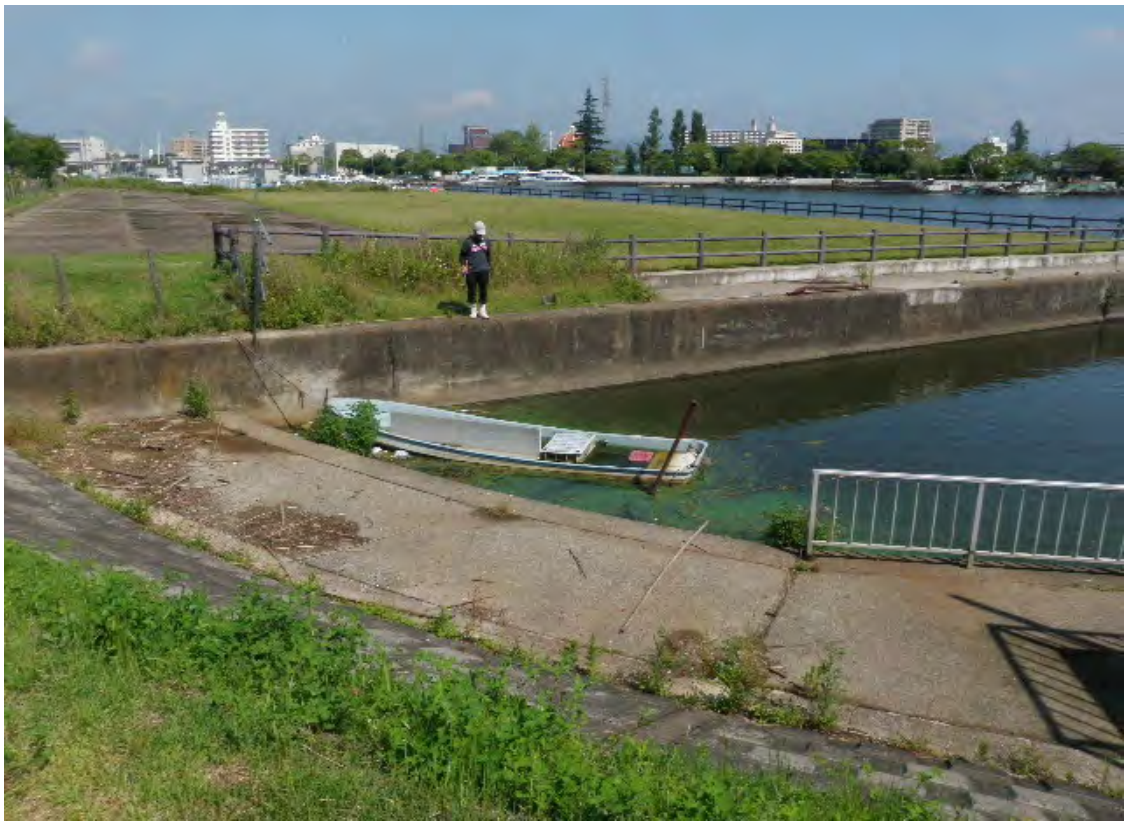
西浦中岸0.75付近 不動前樋管(遠景) レベル3 悪臭無し
