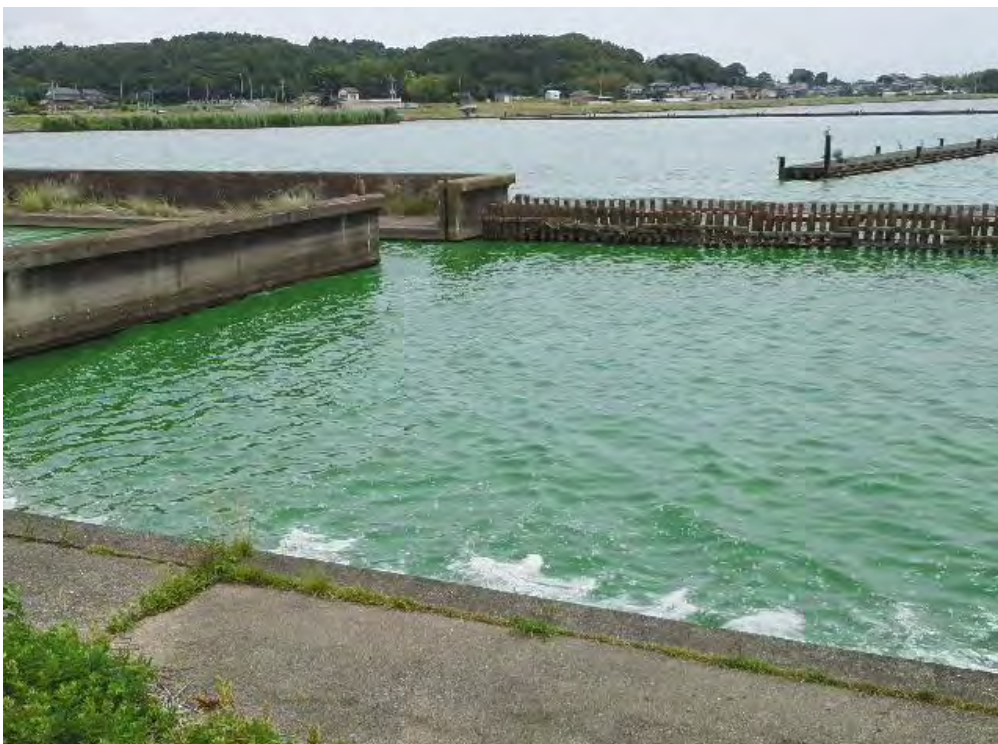
北浦右岸29.25km30m小舟津鶴ヶ居舟溜り下流側アオコ状況 レベル: 2 悪臭: 無
