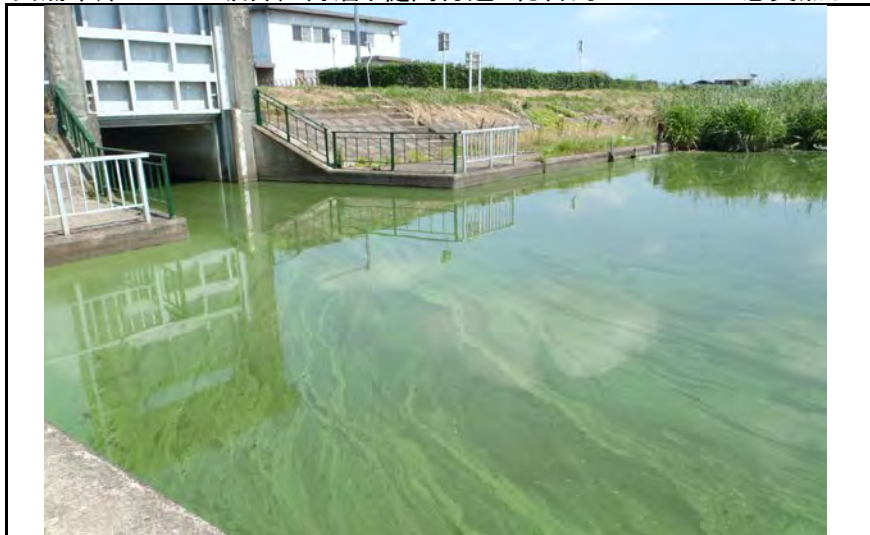
西浦中岸36.50km坂井戸舟溜り樋門付近 総合的にレベル3 悪臭無し
