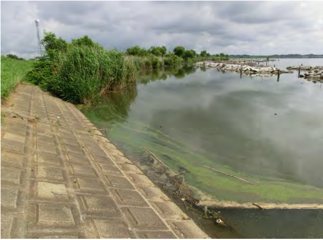
西浦右岸48.00km上 レベル2~3 悪臭無し
