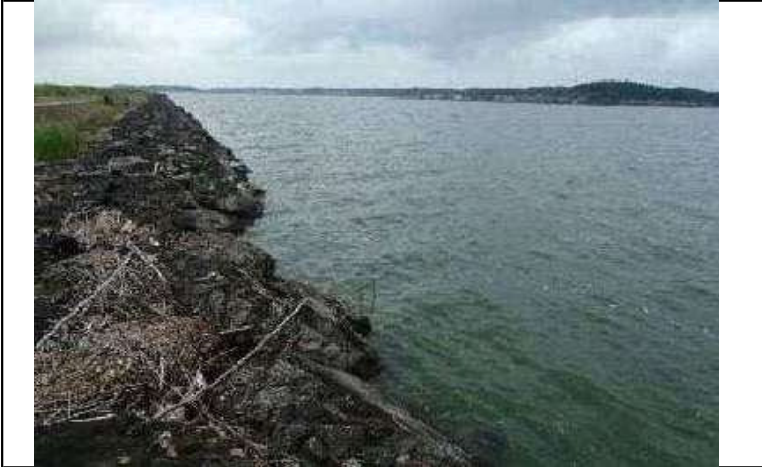
中岸33.75km付近 レベル3 悪臭無し
