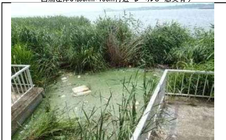
西浦左岸34.00km+150m付近 レベル6 悪臭有り
