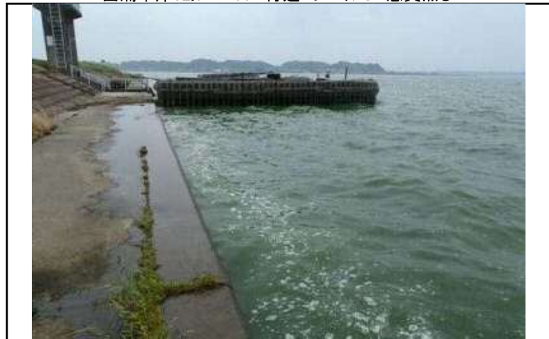
西浦中岸32.5km+50m付近 レベル3 悪臭無し
