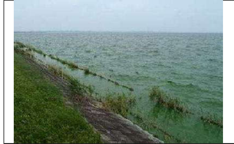
西浦中岸32.25km+30m付近 レベル4 悪臭無し
