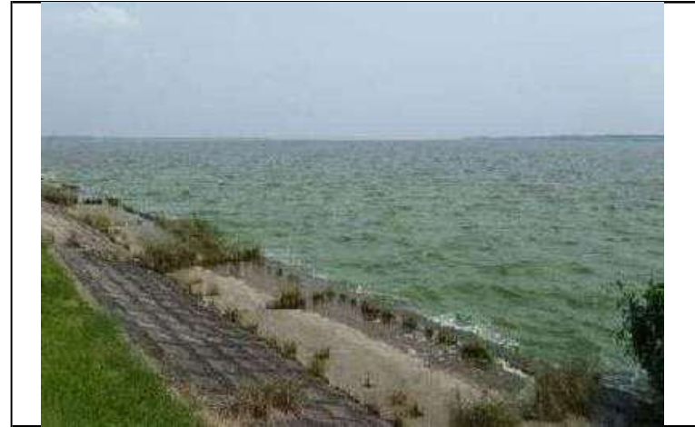
西浦左岸29.50km+120m付近 レベル3 悪臭無し
