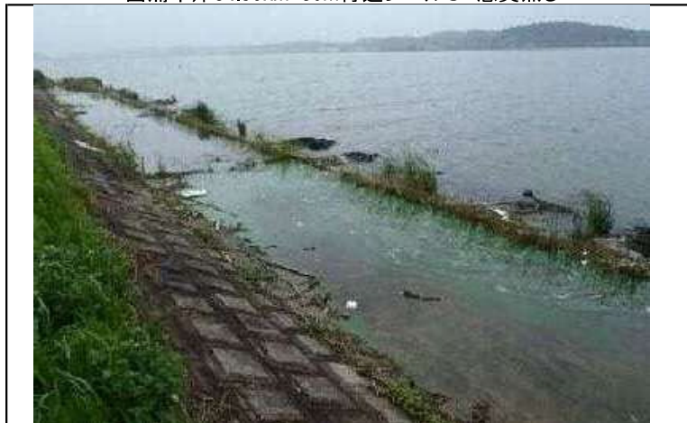
西浦中岸34.50km+30m付近レベル3 悪臭無し
