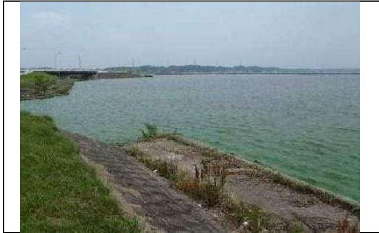
西浦左岸27.75+150m付近 レベル4 悪臭無し
