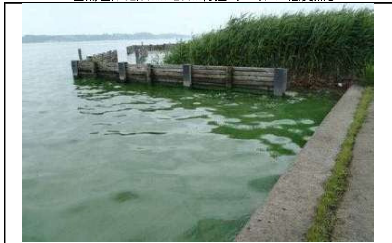
西浦左岸32.00km+200m付近 レベル4 悪臭無し
