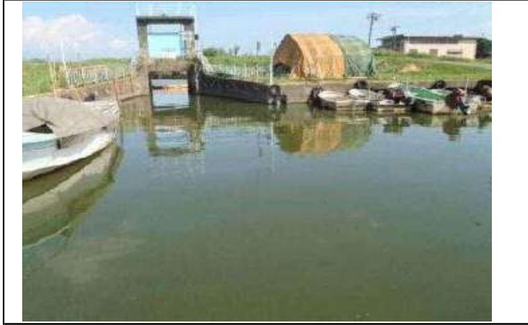
西浦中岸36.5k 坂井戸舟溜まり内 レベル2 悪臭無し
