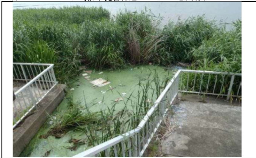
左岸34.00km+150m川島排水樋管付近 レベル6 悪臭有り
