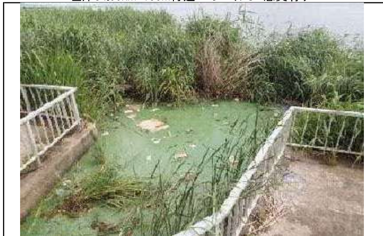
左岸34.00km+150m付近 レベル6 悪臭有り
