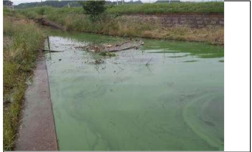
西浦左岸34.75km+200m関川機場付近 レベル4 悪臭無し
