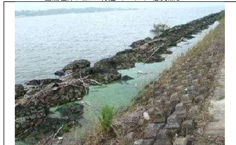
西浦左岸34.25km付近 レベル3 悪臭無し
