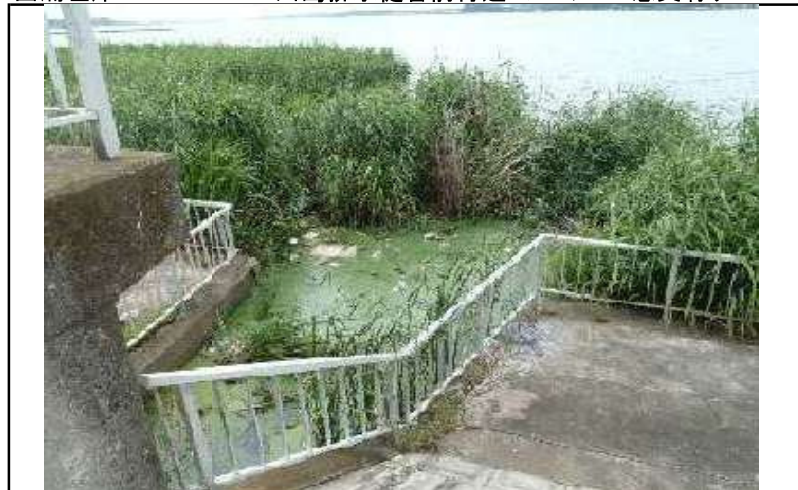
西浦左岸34.00km+150m川島排水樋管前付近 レベル6 悪臭有り
