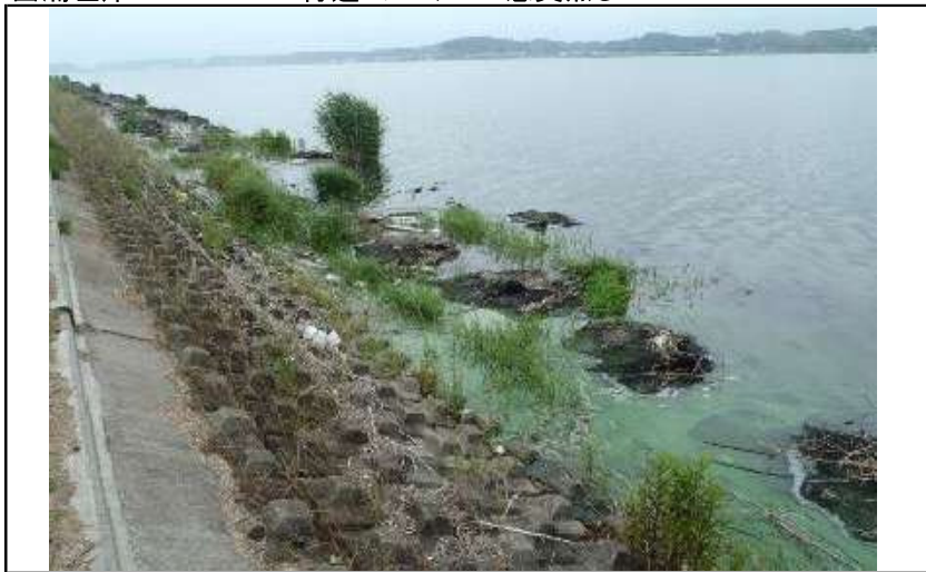
西浦左岸33.75km+40m付近 レベル4 悪臭無し
