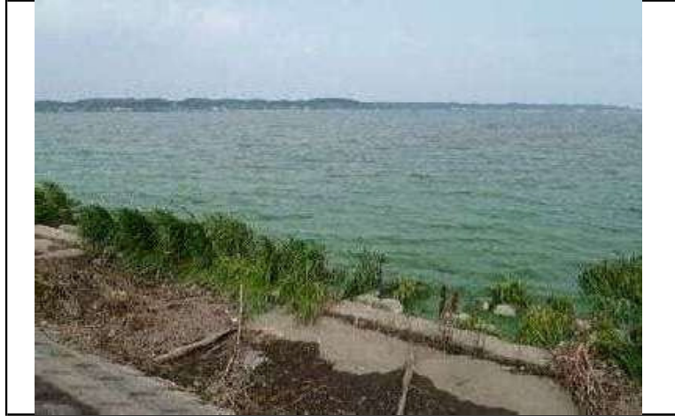
西浦中岸34.50km付近 レベル3 悪臭無し
