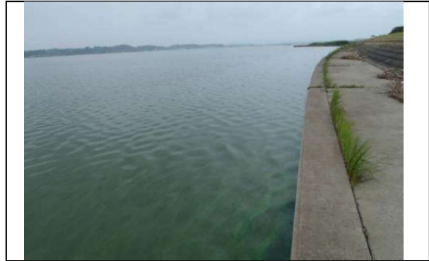
西浦左岸32.00km+120m付近 レベル3 悪臭無し
