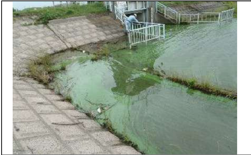
西浦中岸36.25km+100m坂井戸船溜まり樋門付近 レベル4 悪臭無し
