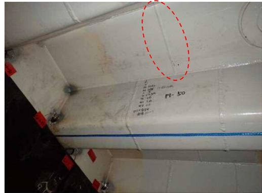
図-12 デッキプレートの板継ぎ溶接部
