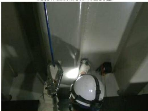
デッキ下面にリアエンコーダを設置し、探触子をマニュアル操作することにより半自動探傷を実施
