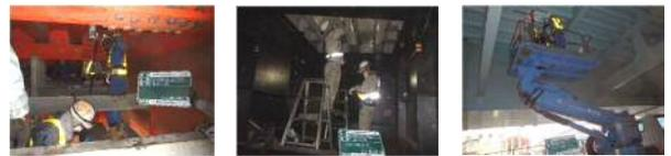
A: 吊足場上 B: 箱桁内脚立 C: 高所作業車(ゲッキタイ) D: 高所作業車(バケットタイプ)
