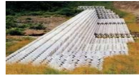
コンクリートブロックを用いた砂防堰堤
