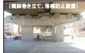
(橋脚巻き立て、落橋防止装置)
