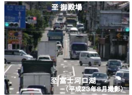
国道138号の交通状況 (上宿交差点付近)
