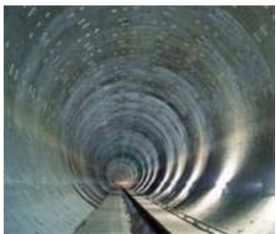
雨水貯留管(和田弥生幹線 中野区・杉並区)
