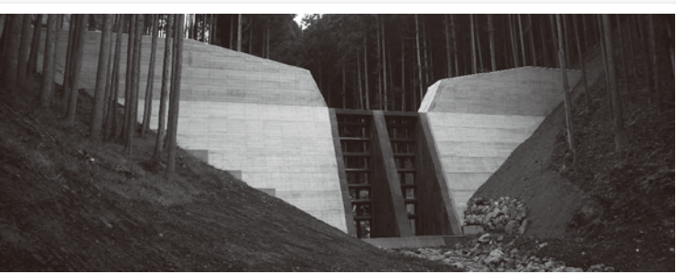
●日暮沢砂防えん堤(高さ14m、幅64m)
