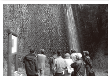
●榛川上流砂防堰堤(登録有形文化財)の見学
