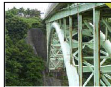
アーチ橋の腐食状況
