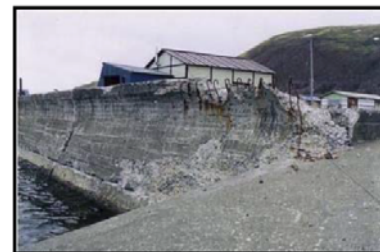
老朽化した海岸堤防
