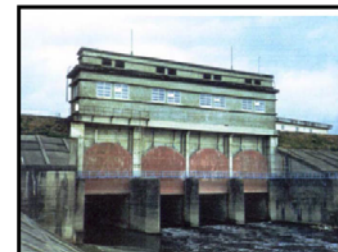
樋門の老朽化
