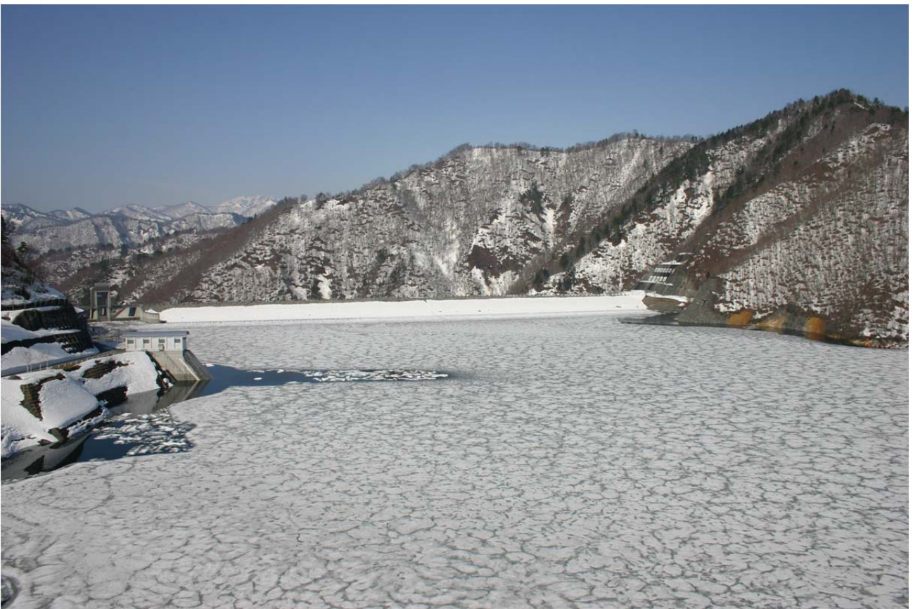
奈良俣ダム（平成27年4月16日撮影）
