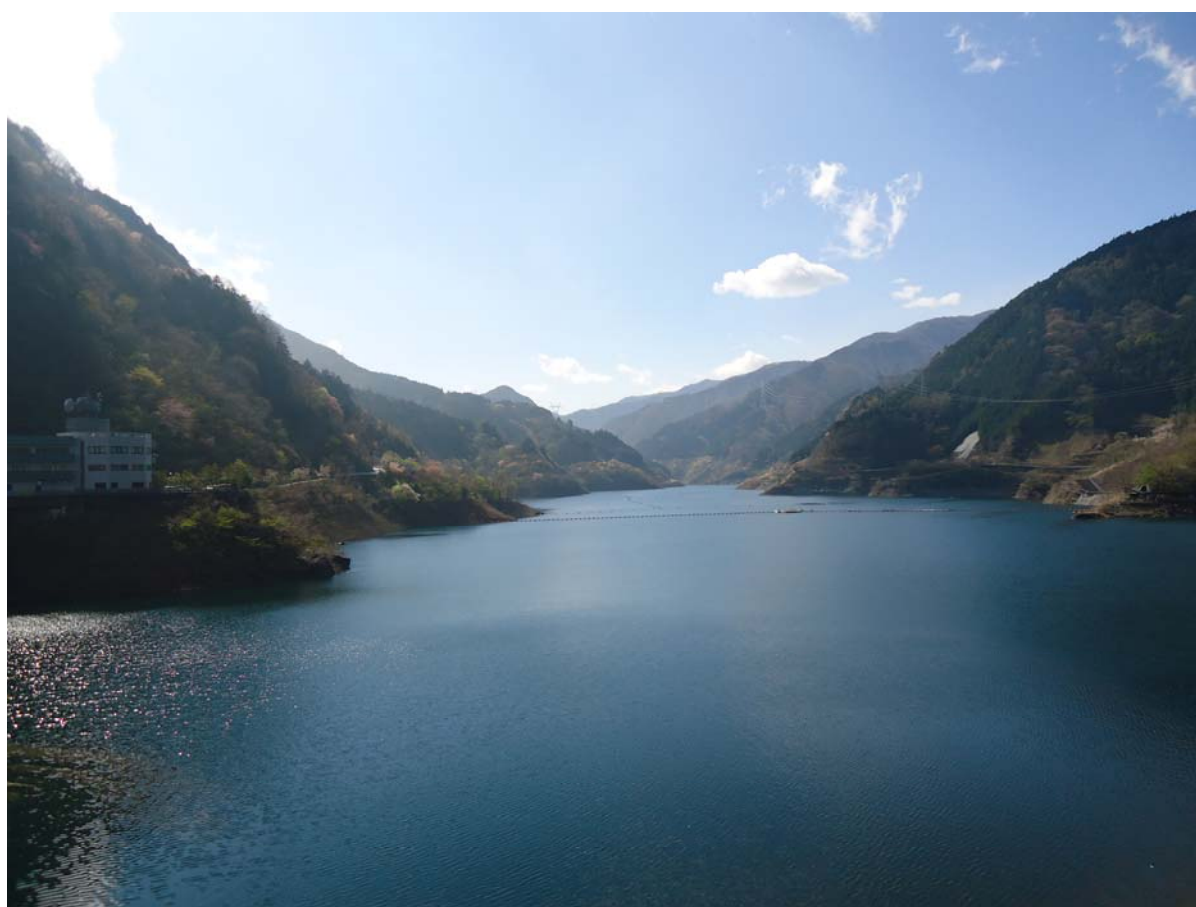
浦山ダム(平成27年4月15日撮影)
