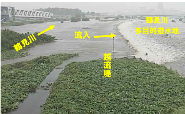
鶴見川の水位が上昇し、越流堤から鶴見川多目的遊水地に流入
