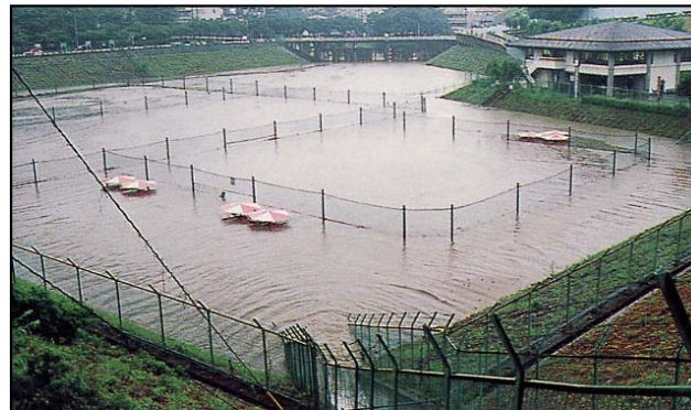
テニスコートを利用して一時的に雨水を貯留
