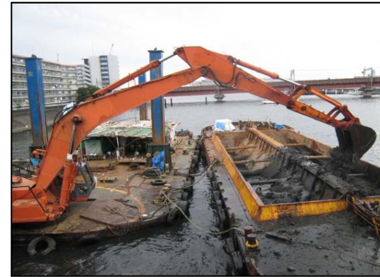
河道掘削により流下能力を増大
