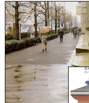
透水性舗装により、雨水を地面に浸透
