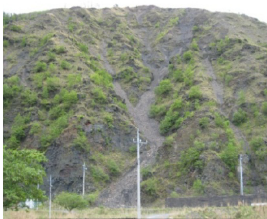
工事前の久蔵口
