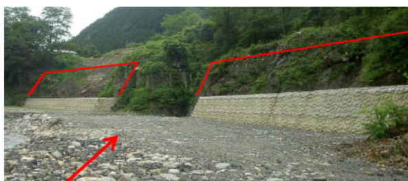
工事前の砂畑護岸
