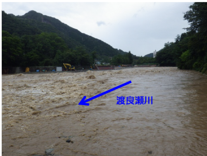
平成25年9月16日 台風18号による出水状況
