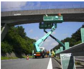
点検実施状況
