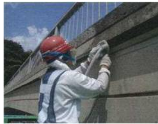
補修実施状況
