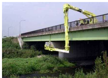
橋梁を定期的に点検し、損傷状況を把握。
