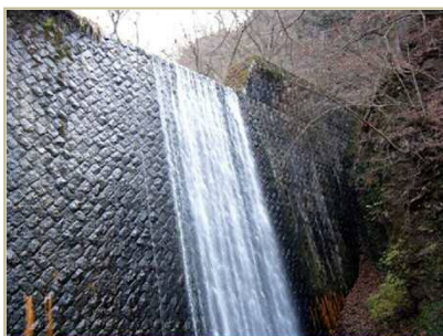
榛名川上流砂防堰堤
