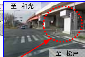
国道298号上り線からの交差側直進交通の視認性が悪い。
