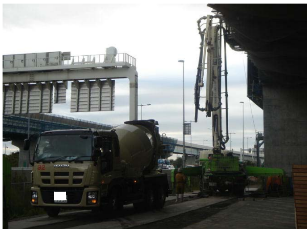
（コンクリート車と圧送ポンプ車）
