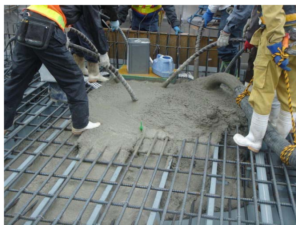
（バイブレータにより締め固め）
