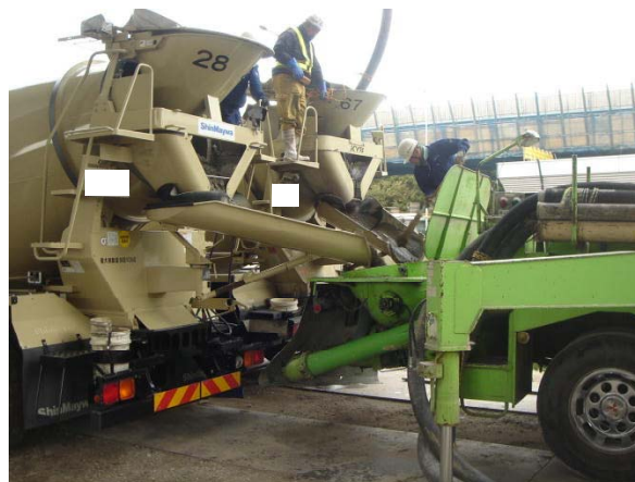
（圧送ポンプ車にコンクリートを投入）
