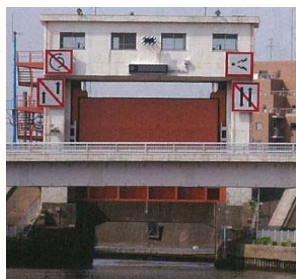
【船舶の通航方法の例】 河川標識
