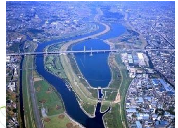
荒川第一調節池 (F,W(埼玉県・東京都)) 治水容量 3,900万m 3 完成年 平成16年
