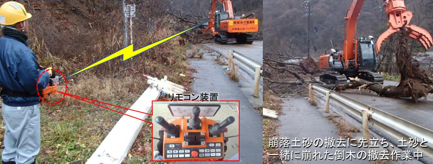
崩落土砂の撤去に先立ち、土砂と一緒に崩れた倒木の撤去作業中
