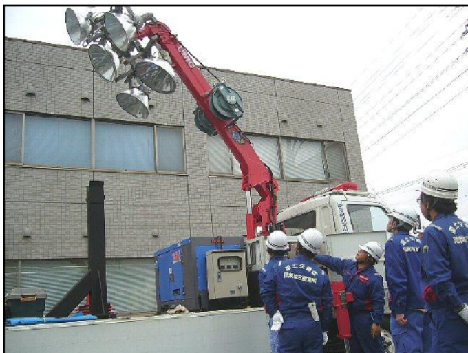
照明車の展開訓練状況
