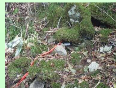
A-37の新設状況 平成24年7月12日
